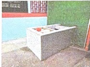
Foto 3: SUMINISTRO E INSTALACIÓN DE PILA MÁS AZULEJO, APLICACIÓN DE PINTURA EN MUROS INTERIORES Y EXTERIORES
