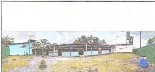
Foto1: VISTA PANORÁMICA DEL ESTABLECIMIENTO, APLICACIÓN DE PINTURA EN MUROS EXTERIORES E INTERIORES
