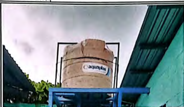
Foto 7: Cambio e instalación de depósito de agua de 1700 lts, finalizado al 100%
