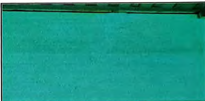
Foto 10: Sellado de grietas y fisuras en muros, finalizado al 100%.
