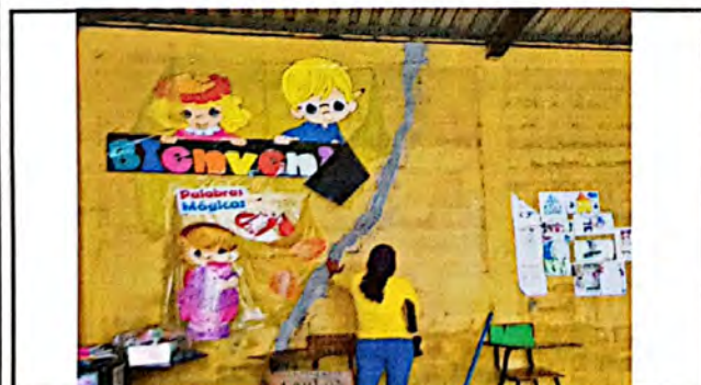
Foto 11: Sellado de gnetas y fisuras en muros. Avance en su proceso de ejecución.
