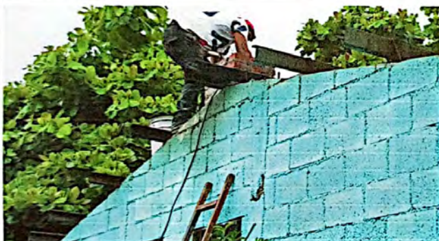
Foto 9: Mantenimiento a estructura de soporte de metal (lijado, pintura anticorrosiva) en el módulo de cocina.
