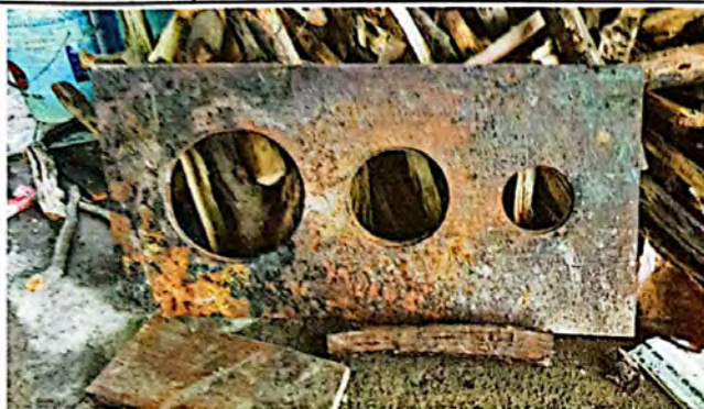
Foto 7: Se le dará el mantenimiento adecuado a la plancha existente de la estufa de leña rural, ya que aun se encuentra en buen estado.
