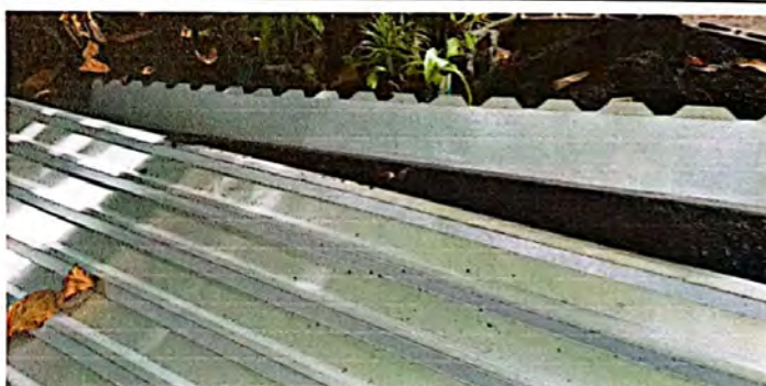
Foto 10: Cambio e instalación de lamina por lamina troquelada aluzinc calibre 26, incluye tornillo. Láminas y capotes preparados para iniciar su instalación.
