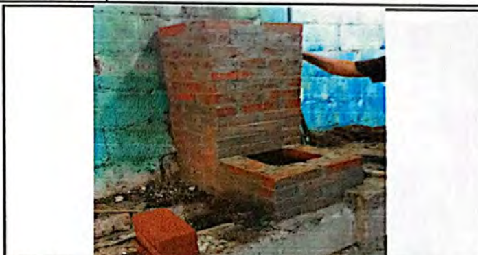
Foto 8: Mejoramiento de modulo de cocina, incluye remozamiento de estufa de leña rural, muebles de concreto fijo y azulejo, proceso de construcción de la chimenea.
