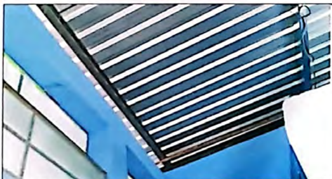
Foto 5: Módulo de sanitarios, mantenimiento e instalación de estructura de metal incluye lijado y pintura anticorrosiva concluido al 100%
