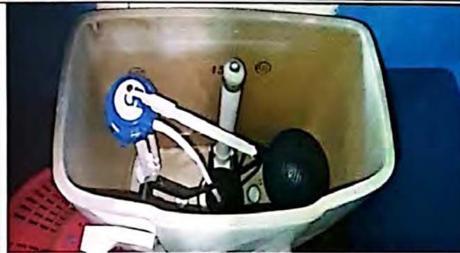
Foto 2: Cambio e instalación de kit para inodoros, incluyendo conexión de tubería, finalizado al 100%.
