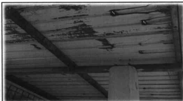
Foto 5: Mantenimiento e Instalación de estructura de metal incluye lijado y pintura anticorrosiva.
