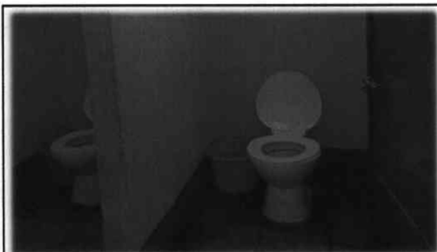
Foto 3: Debe mejorarse los servicios sanitarios con cambio e instalación de kit para inodoros, incluye conexión de tubería.
