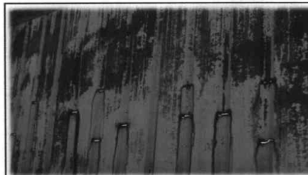
Foto 6: Es necesario el suministro e Instalación de lámina troquelada Aluzinc calibre 26 (incluye tornillos).
