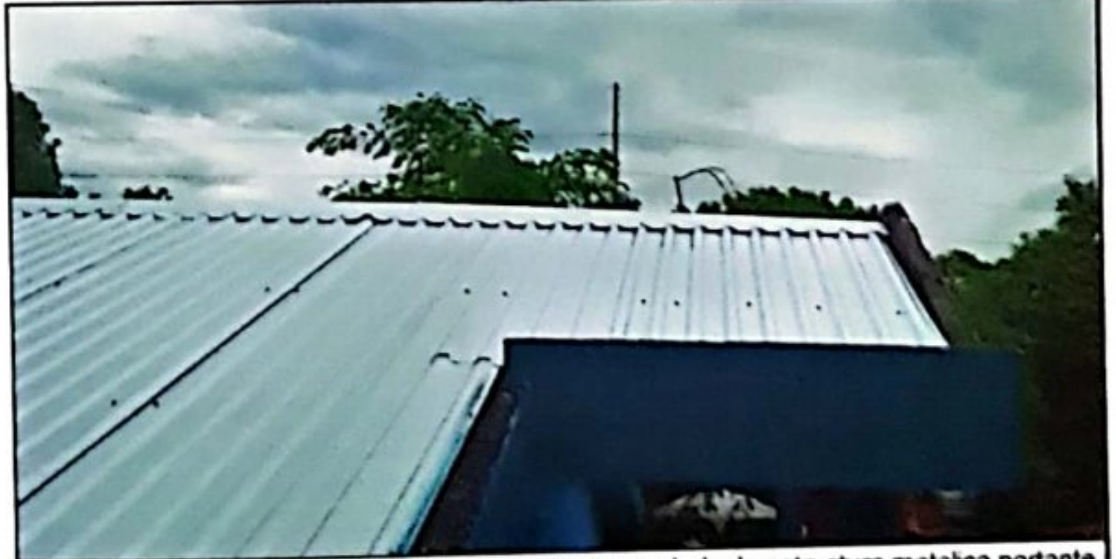
Foto 6: otro ángulo de la instalación de lámina troquelada, la estructura metálica portante, también recibió mantenimiento y reparaciones.
