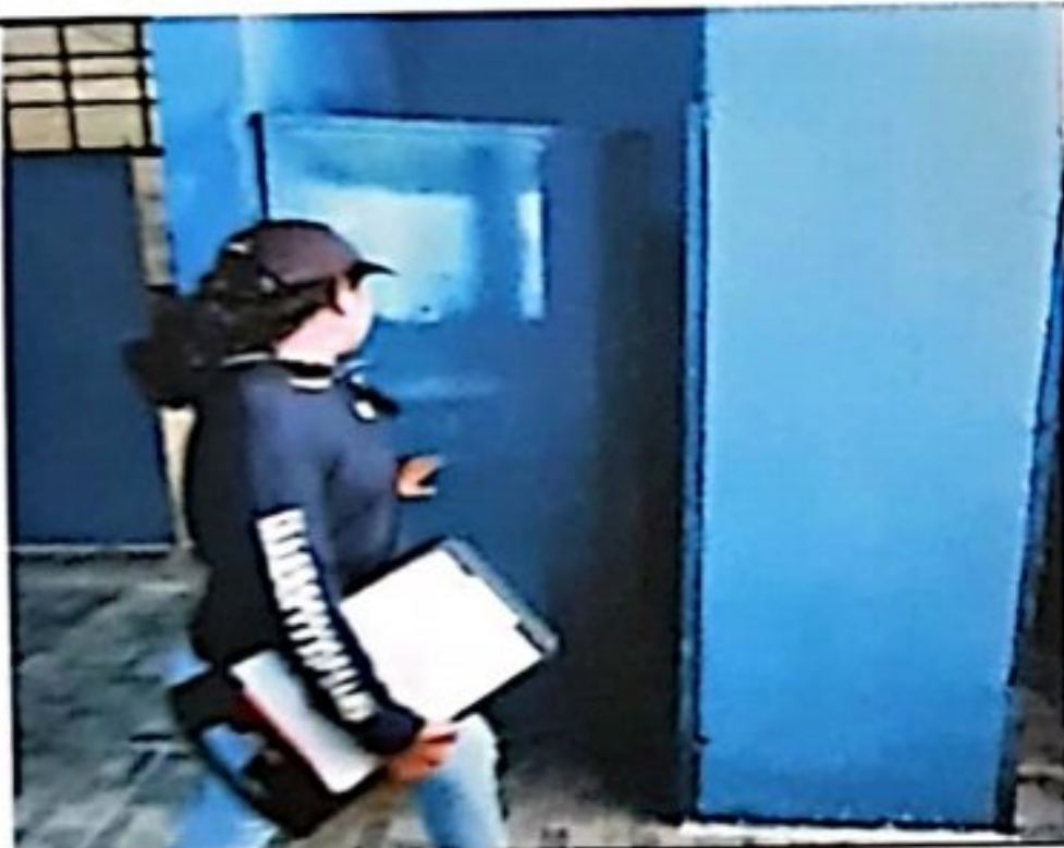
Foto 3: Herrería, Reparación y mantenimiento de puertas en el módulo de servicios sanitarios (0.75 m x 1.70 m) finalizado al 100%
