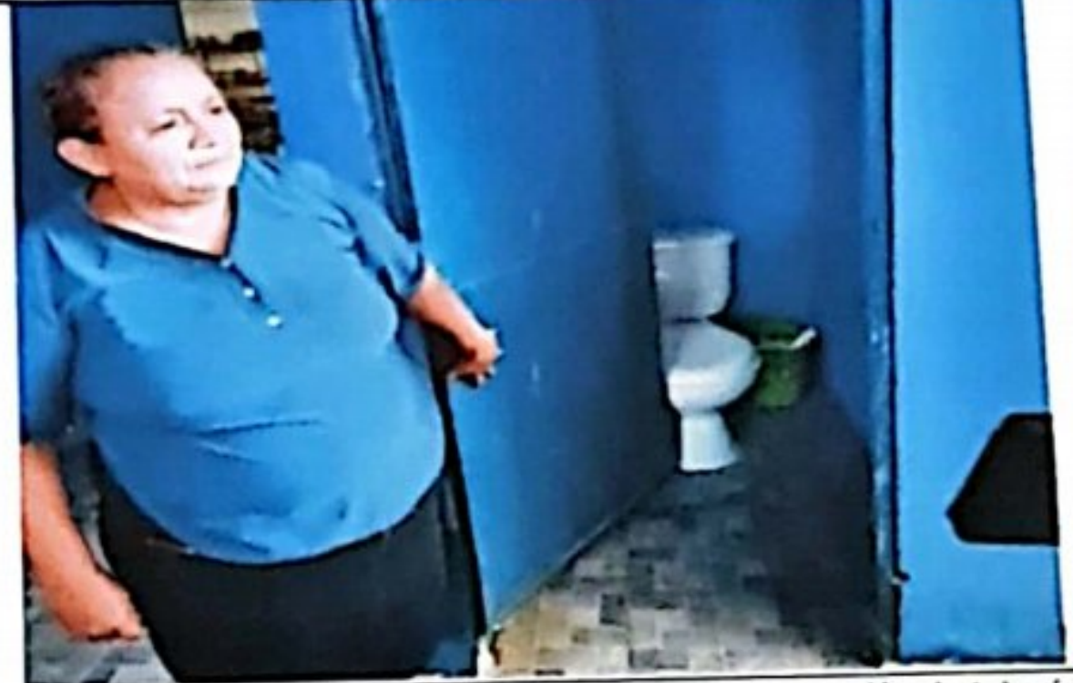
Foto 2: Cambio e instalación de kit para inodoros, incluye conexión de tubería finalizada al 100%
