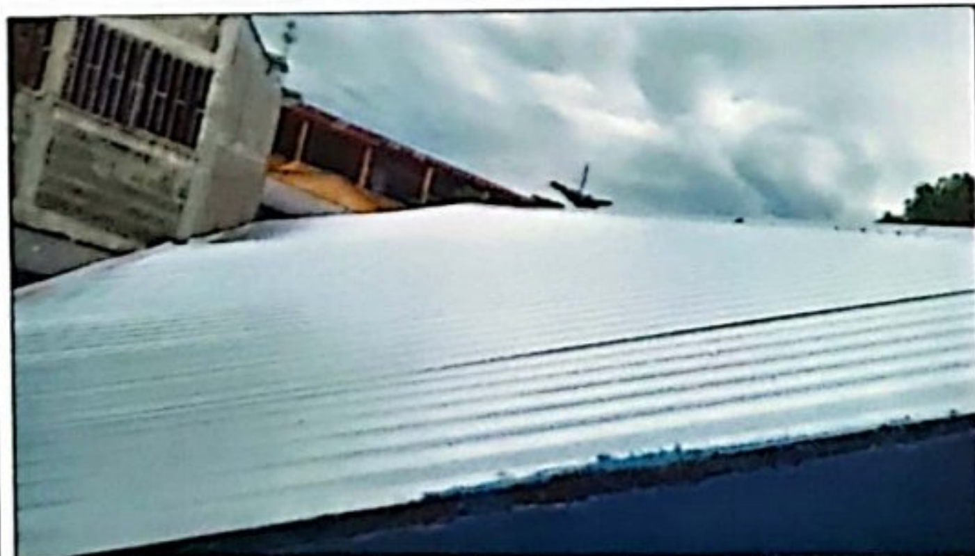
Foto 5: Se observa el resultado concluido del suministro e Instalación de lámina troquelada Aluzinc calibre 26, ejecutado al 100%.
