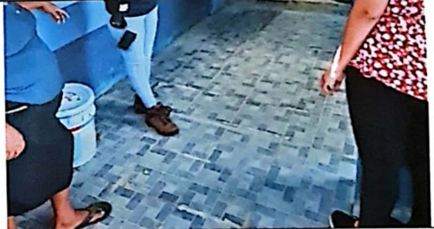
Foto 4: Se observa el trabajo de cambio e instalación de piso antideslizante (4.80 m x 3.9 m) finalizado al 100%.
