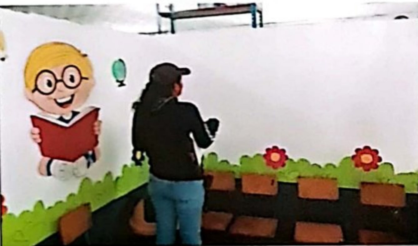
Foto 9: Suministro e instalación de divisiones en modulo de aulas con muro tabique de 10cm x 20cm x 40cm finalizado al 100%, cabe mencionar que es trabajo extra llamado de otra manera remanente.
