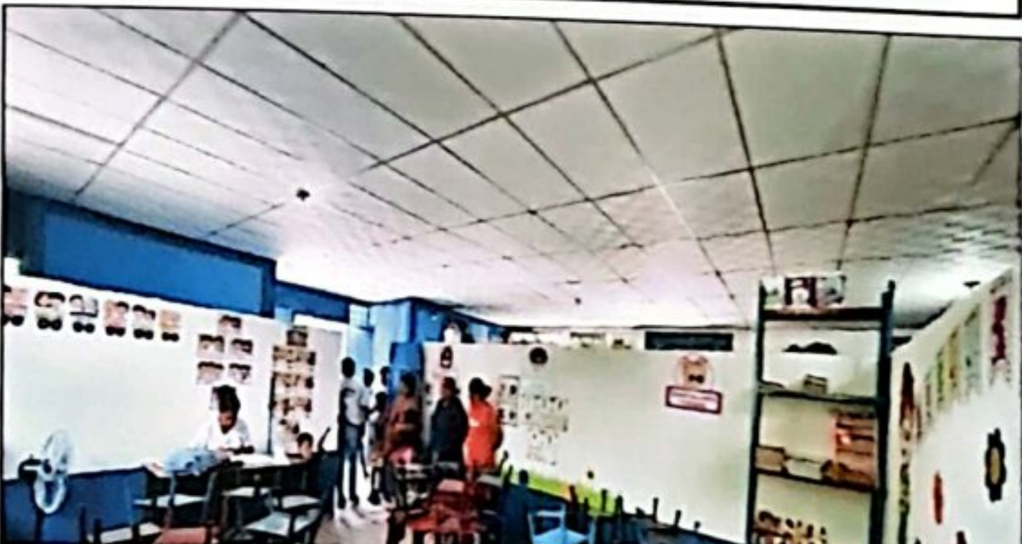
Foto 10: Suministro e instalacion de cielo falso en el modulo de aulas concluido al 100%, cabe mencionar que es trabajo extra llamado de otra manera remanente.
