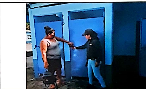
Foto 4: Herrería, Reparación y mantenimiento al 100% de puertas metálicas en el módulo de servicios sanitarios (0.64 m x 1.50 m). Finalizado.
