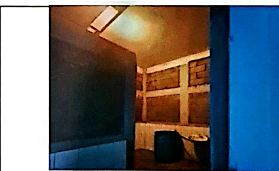
Foto 6: Se observa el módulo de servicios para maestros y el suministro e instalación de sistema eléctrico iluminación (incluye ducto y/o tubos de PVC, cajas octogonales, abrazaderas, cables, interruptores, plafonera con foco, finalizado).
