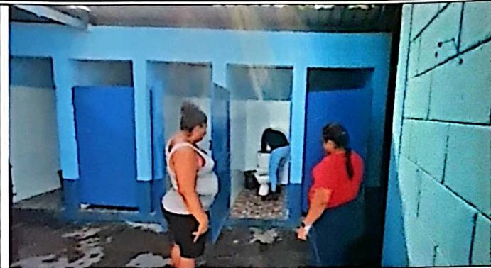
Foto 2: Se revisan los trabajos de reparación y mejoramiento de servicios sanitarios, incluye reparaciones, cambio de tubería, artefactos. Finalizado al 100%
