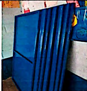
Foto 2: Herrería, reparación y mantenimiento de puertas en servicios sanitarios.
