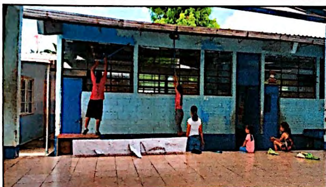
Foto 9: Se observar avances en el proceso de pintura en el exterior de aulas. Cabe mencionar que es un trabajo adicional ala PARA-FOR-85.
