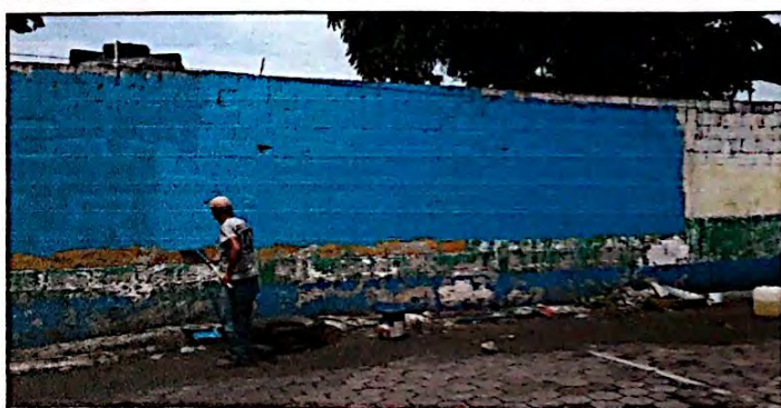
Foto 10: Mantenimiento, pintura en muro perimetral exterior e interior ( 2 manos).
