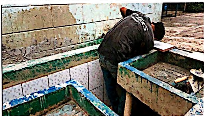
Foto 5: Se observa que se prepara la superficie adecuadamente para la instalación de azulejo en pileta.
