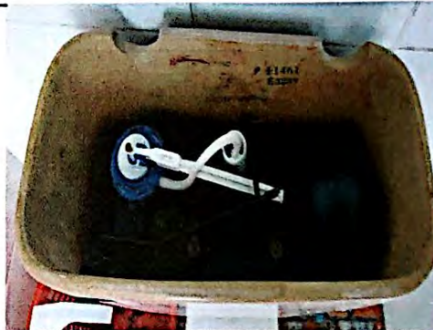
Foto 4: Reparación y mejoramiento de servicios sanitarios, accesorios para el correcto funcionamiento de los inodoros.
