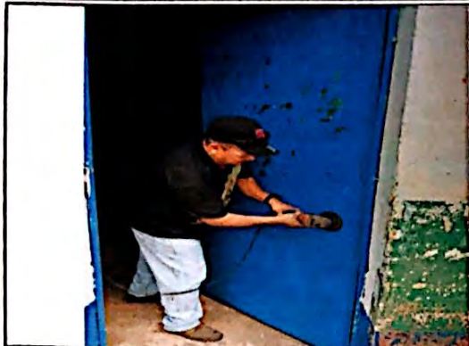
Foto 7: Herrería, reparación puertas y balcones, incluye lijado y pintura.
