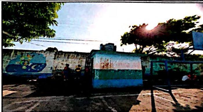
Foto 8: Se observa que se tiene el deposito de agua mas sin embargo esta en proceso su conexión al circuito de agua potable.
