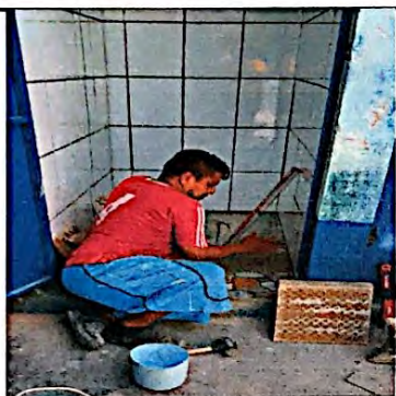
Foto 3: Cambio e instalación de piso antideslizante en servicios sanitarios. Avance en su ejecución.
