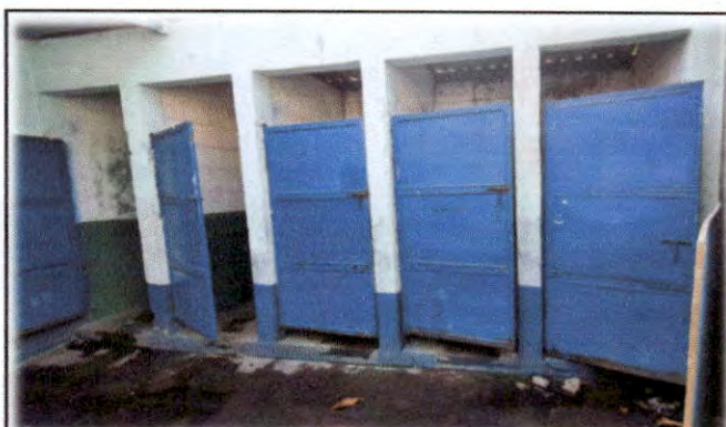
Foto 4: Es necesaria la reparación y mantenimiento de puertas en el módulo de servicios sanitarios.
