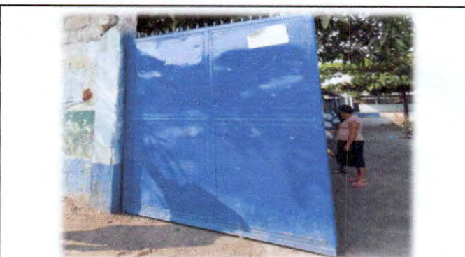
Foto 11: Se detecta la necesidad de la reparación de columnas principales de apoyo para el portón y el cambio e instalación del portón metálico.
