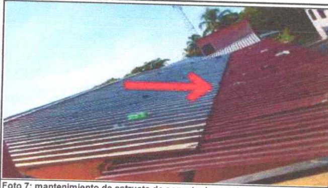
Foto 7: mantenimiento de estructura de soporte de metal
