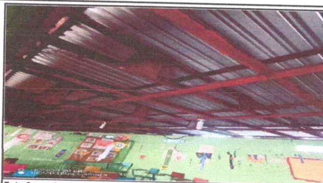
Foto 2: sustitucion de lámina y sustitucion de estructura de soporte de madera por metal de las cuatro aulas
