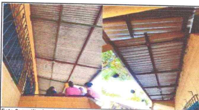
Foto 6: sustitucion de lamina troquelada.
