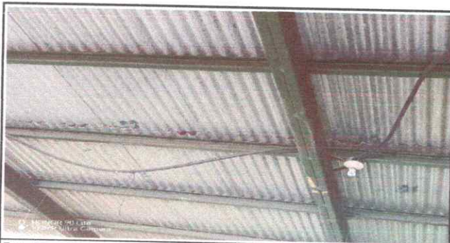
Foto 5: sustitucion de lamina troquelada.
