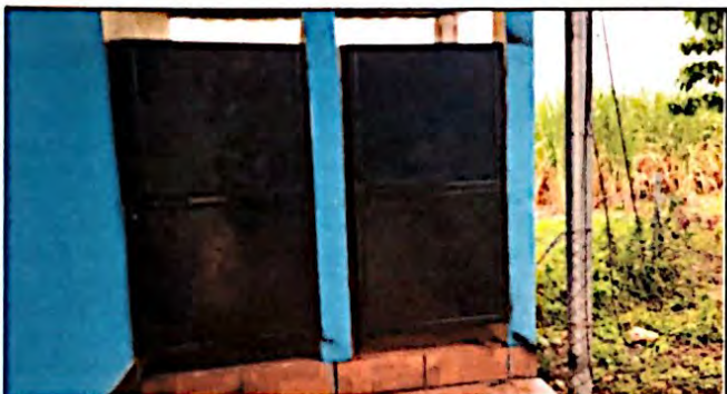
Foto 3: Herrería. Reparación y mantenimiento de puertas (1.50 m x 0.80) en el módulo de baños, finalizado al 100%
