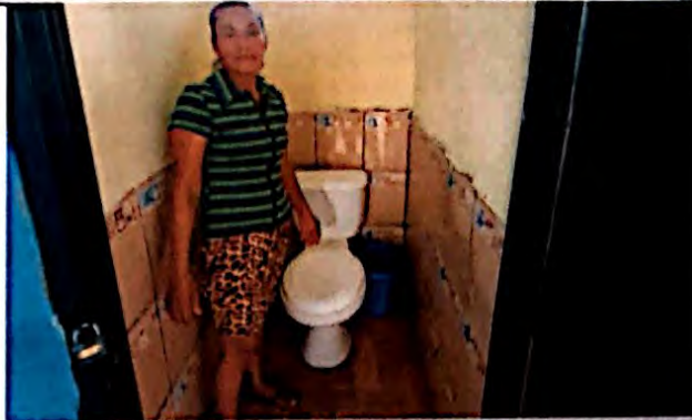
Foto 2: Cambio e instalación de inodoro finalizado al 100%
