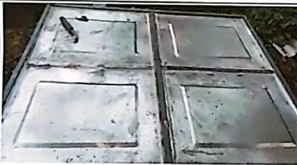
Foto 9: Avance de los trabajos de herrería, para la sustitución de ventanas y balcones.
