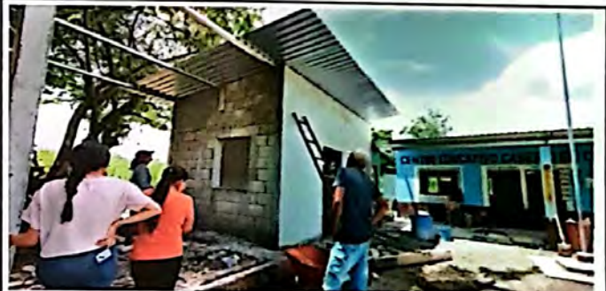
Foto 10: Se continua el recorrido dejando algunos observaciones de mejoras para la ejecución del remozamiento.
