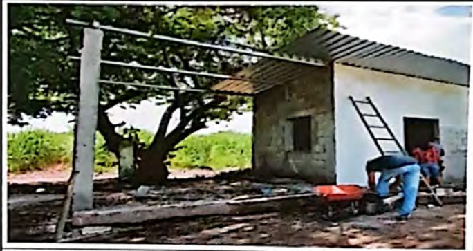
Foto 8: Suministro e instalación de estructura metálica portante y lamina troquelada aluzinc calibre 26 en área de las pilas a instalar.
