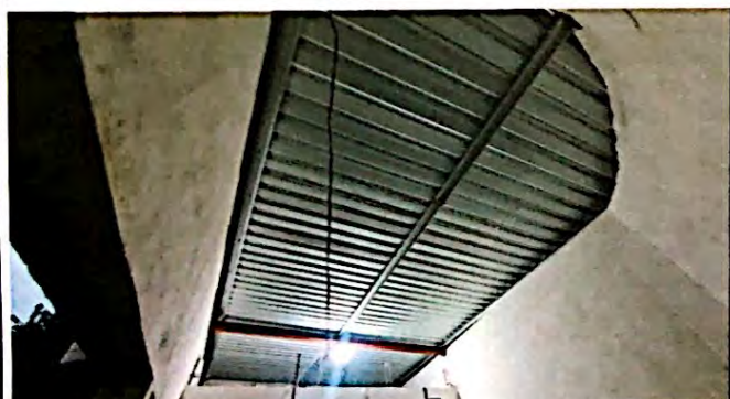
Foto 5: Cambio e instalación de lamina por lamina troquelada aluzinc calibre 26 (incluye pernos) en el módulo de baños, finalizado al 100%
