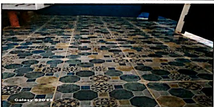
Foto 4: Cambio e intalacion de piso ceramico antideslizante en el módulo de baños, finalizado al 100%
