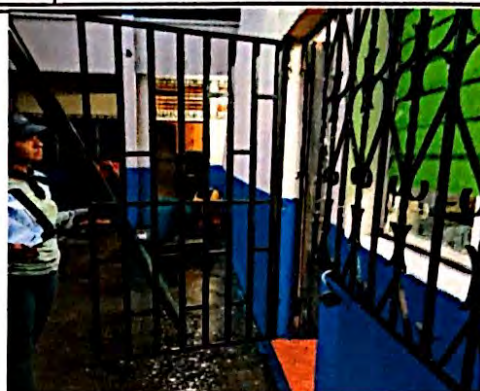
Foto 8: Cambio e intalacion de puerta tipo reja para cocina. Finalizada al 100%
