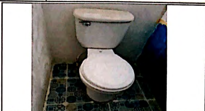
Foto 2: Mejoramiento en módulos de servicios sanitarios ( incluye reparación, cambio de tubería artefactos, azulejo y reparación de muros divisores). Finalizada al 100%
