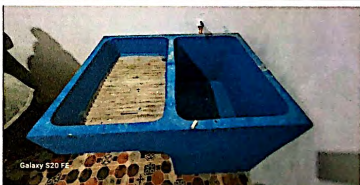
Foto 10: Cambio e instalación de de pilas de concreto en el módulo de cocina. Finalizado al 100%
