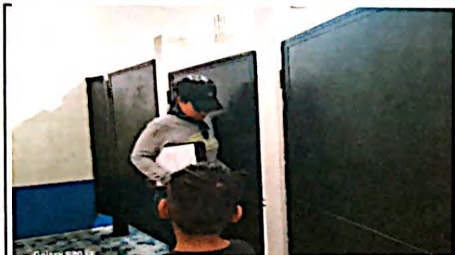
Foto 3: Herrería. Reparación y mantenimiento de puertas (1.50 m x 0.80) en el módulo de baños. Finalizada al 100%
