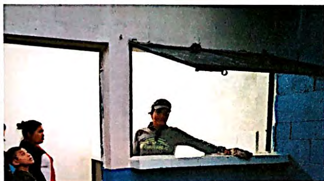
Foto 9: Cambio e intalacion ventana metalica para despacho en el módulo de cocina. Finalizada al 100%
