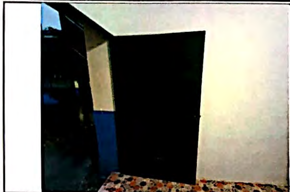
Foto 7: Herrería. Reparación y mantenimiento de puertas (1.50 m x 0.80) en el módulo de cocina. Finalizada al 100%
