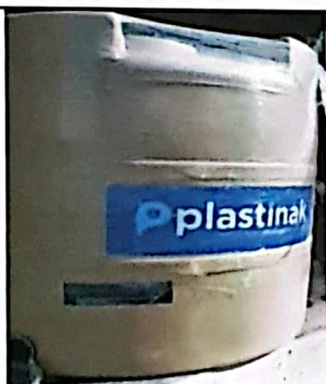
Foto 11: Se observa que se tiene como remanente la Sustitución de deposito de agua potable mas accesos.
