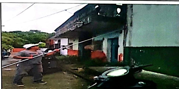
Foto 10: Se observa avance en la limpieza de muros para luego aplicarte pintura en muros exteriores e interiores ( 2 manos ).
