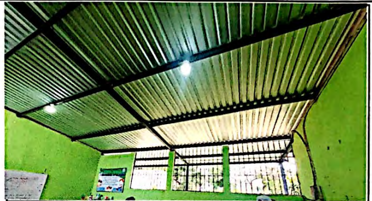
Foto 2: Cambio e instalación de lamina por lamina troquelada aluzinc calibre 26 (incluye tornillos) en el 1er módulo de aulas, finalizado al 100%
