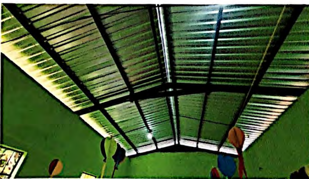
Foto 5: Cambio e instalación de lamina por lamina troquelada aluzinc calibre 26 (incluye tornillos) 2do módulo de aulas, finalizado al 100%
