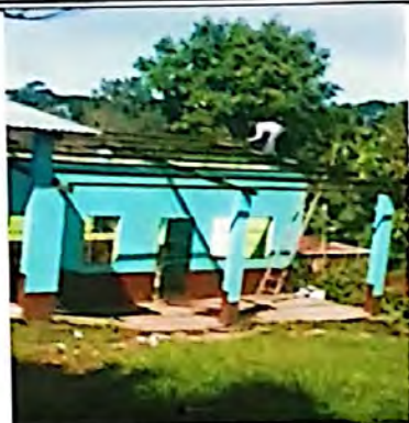
Foto 7: Desmontaje de lamina existente para la instalación de lamina troquelada aluzinc calibre 26.
