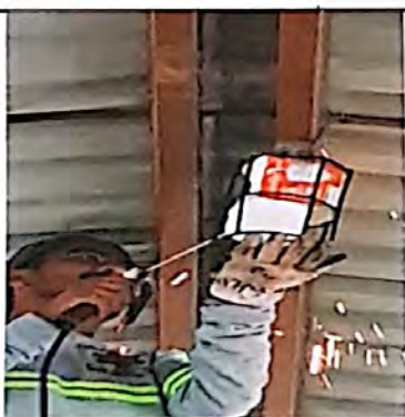
Foto 11: Se observan las protecciones colocadas en los fijos de los pasillos para evitar robos.
