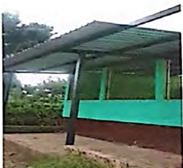
Foto 9: Cambio e instalación de lamina por lamina troquelada aluzinc calibre 26 (incluye tornillos) en 4to módulo de aulas.
