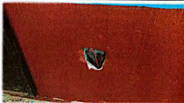
Foto 8: Reparación de circuito eléctrico iluminación y fuerza ( incluye ducto o tubo PVC, plafoneras con focos ahorradores alta potencia, abrazaderas cables, interruptores y tomacorrientes.
