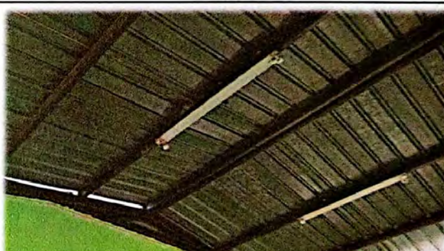
Foto 10: Reparación de circuito eléctrico iluminación y fuerza ( incluye ducto o tubo PVC, plafoneras con focos ahorradores alta potencia, abrazaderas cables, interruptores y tomacorrientes.
