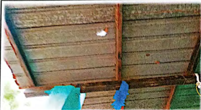
Foto 7: Es necesario el cambio e instalación de lámina por lámina troquelada aluzinc calibre 26 (incluye tornillos) en el tercer módulo de aulas.
