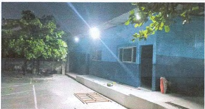
Foto 17: 17.12 Sustitución de ducto eléctrico + accesorios
