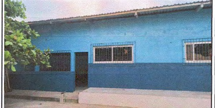
Foto 14: 15.1 Reparación de muro perimetral de block
