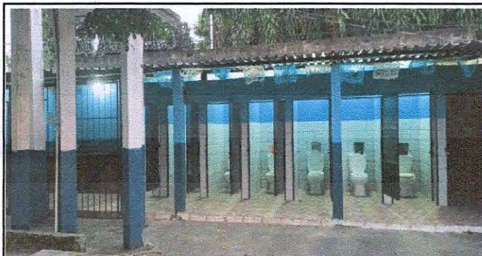
Foto 21: 4.4 SUSTITUCION DE PUERTAS EN SERVICIOS SANITARIOS
