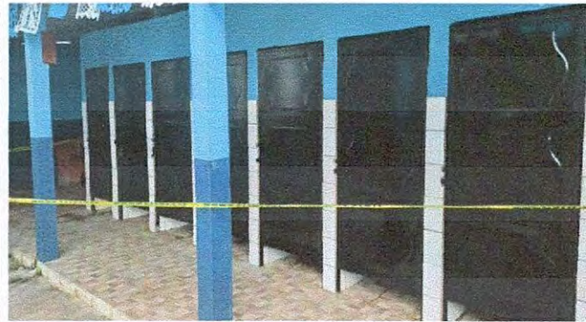
Foto 20: 4.4 SUSTITUCION DE PUERTAS EN SERVICIOS SANITARIOS
