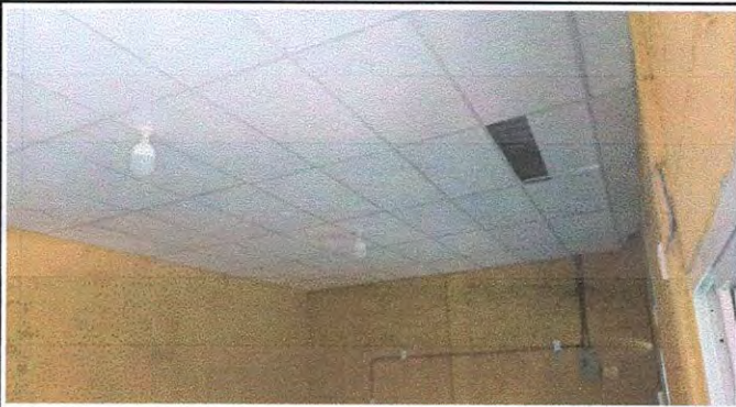
Foto 15: 17.12 Sustitución de ducto eléctrico + accesorios
