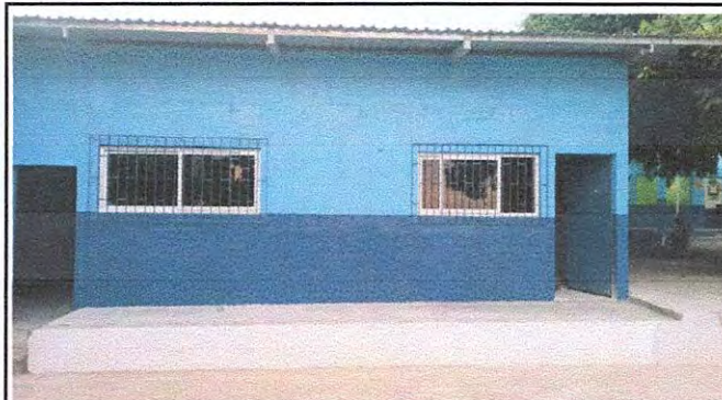
Foto 8: 8.2 Reparación de banquetas de concreto
