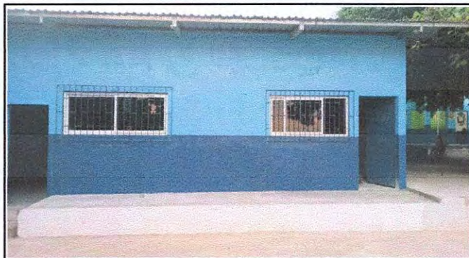
Foto 2: 1.1 Sustitución de lámina por lámina troquelada aluzinc calibre 26 1.3 Sustitución de elementos de fijación
