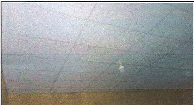
Foto 3: 2.1 Mantenimiento a estructura de soporte de metal
