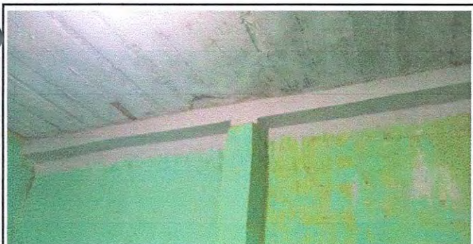
Foto 23: 21.4 SELLADO DE GRIETAS Y FISURAS
