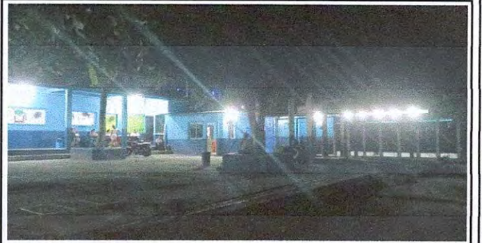
Foto 18: 17.12 Sustitución de ducto eléctrico + accesorios
