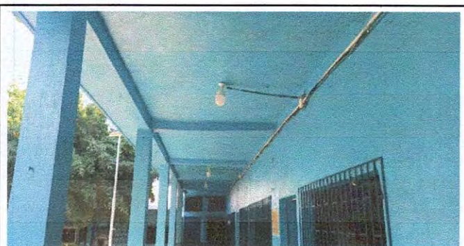
Foto 11: 9.1 Pintura en muros exteriores e interiores
