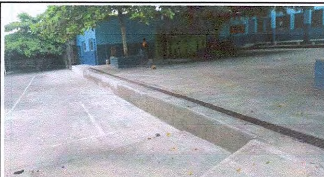
Foto 9: 8.2 Reparación de banquetas de concreto
