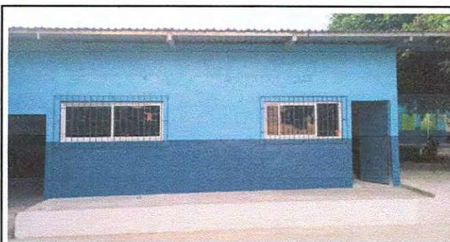
Foto 12: 9.1 Pintura en muros exteriores e interiores
