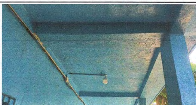
Foto 24: 21.4 SELLADO DE GRIETAS Y FISURAS
