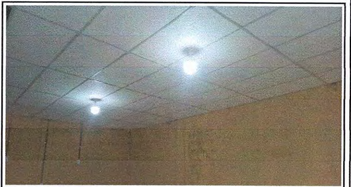
Foto 16: 17.12 Sustitución de ducto eléctrico + accesorios
