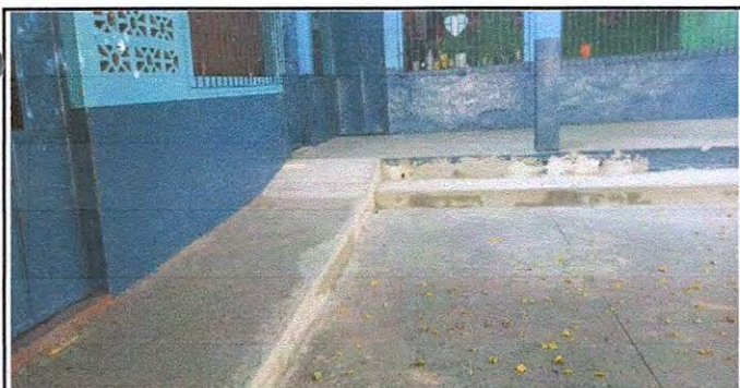
Foto 5: 8.1 Reparación de cuneta de concreto
