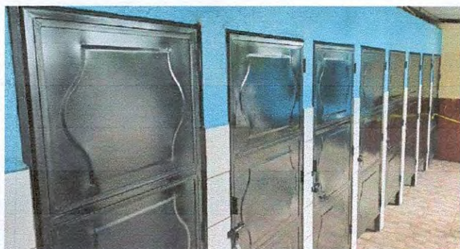
Foto19: 4.4 SUSTITUCION DE PUERTAS EN SERVICIOS SANITARIOS
