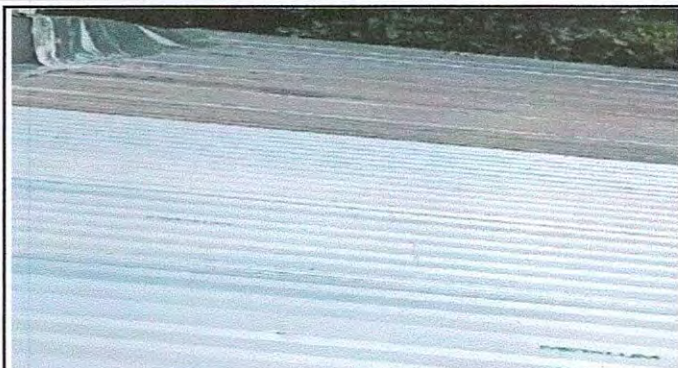
Foto1: 1.1 Sustitución de lámina por lámina troquelada aluzinc calibre 26 1.3 Sustitución de elementos de fijación
