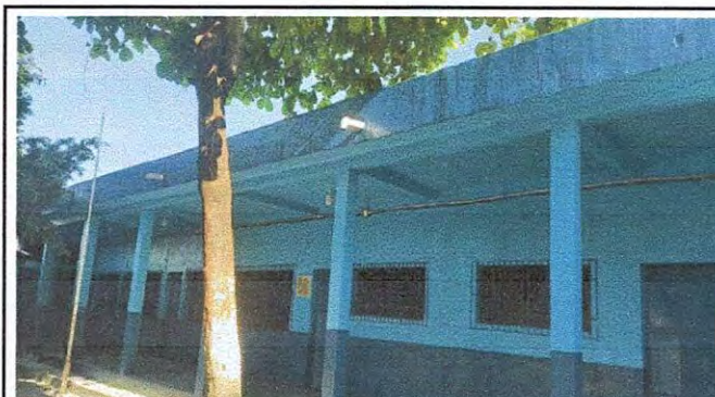
Foto 10: 9.1 Pintura en muros exteriores e interiores
