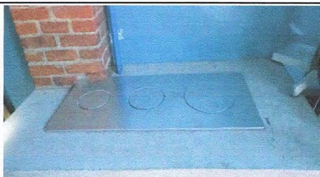
Foto 22: 20.3 SUSTITUCIÓN DE PLANCHA DE METAL
