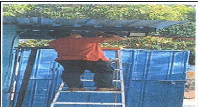
Foto 15: 17.12 Sustitución de ducto eléctrico + accesorios
