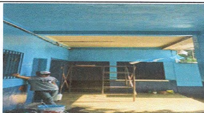
Foto 10: 9.1 Pintura en muros exteriores e interiores
