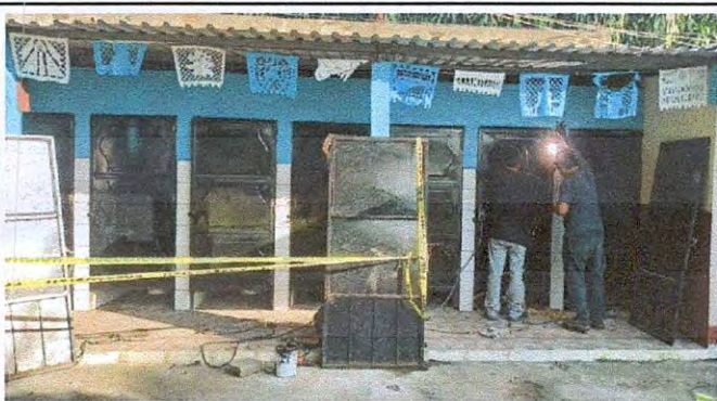
Foto 21: 4.4 SUSTITUCION DE PUERTAS EN SERVICIOS SANITARIOS
