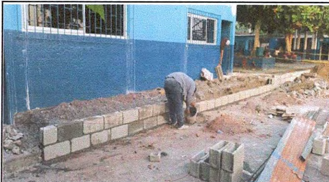
Foto 8: 8.2 Reparación de banquetas de concreto
