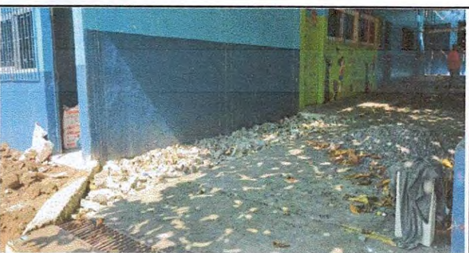
Foto 5: 8.1 Reparación de cuneta de concreto
