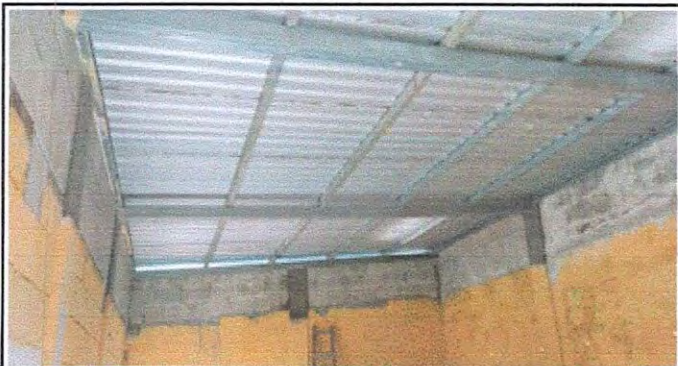
Foto13: 15.1 Reparación de muro perimetral de block
