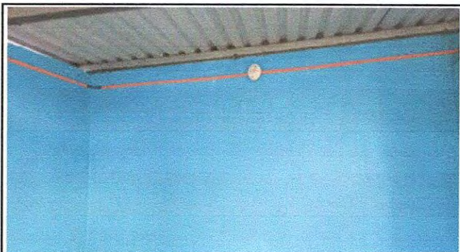
Foto 16: 17.12 Sustitución de ducto eléctrico + accesorios
