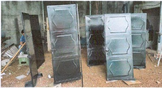
Foto 19: 4.4 SUSTITUCION DE PUERTAS EN SERVICIOS SANITARIOS
