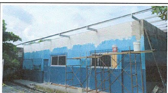
Foto 12: 15.1 Reparación de muro perimetral de block
