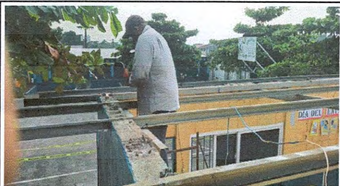
Foto 3: 2.1 Mantenimiento a estructura de soporte de metal
