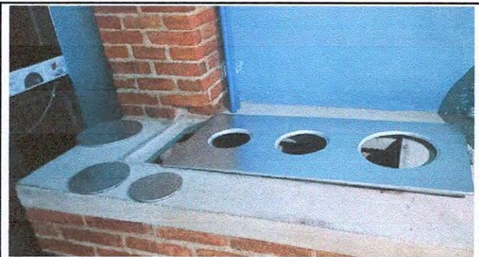
Foto 22: 20.3 SUSTITUCIÓN DE PLANCHA DE METAL
