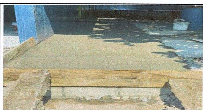
Foto 6: 8.1 Reparación de cuneta de concreto
