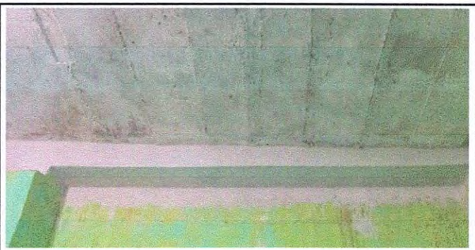
Foto 24: 21.4 SELLADO DE GRIETAS Y FISURAS
