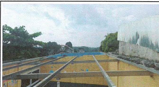
Foto 4: 2.3 Sustitución de estructura de soporte de metal por metal
