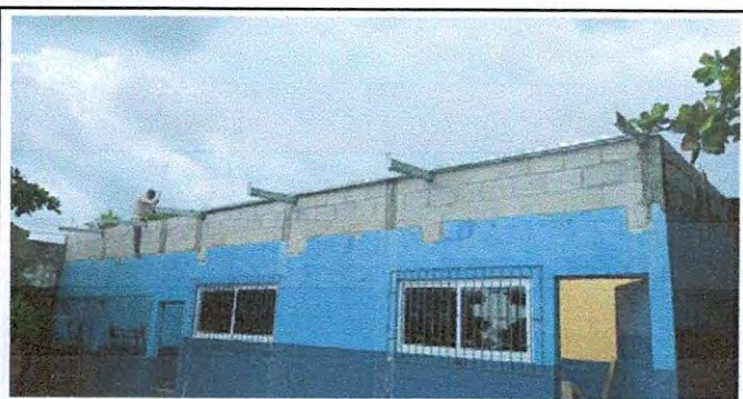
Foto 11: 15.1 Reparación de muro perimetral de block
