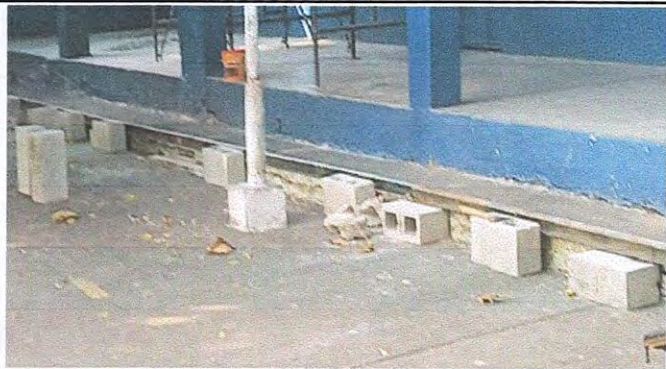
Foto 7: 8.2 Reparación de banquetas de concreto
