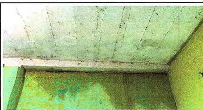
Foto 17: 21.4 Sellado de grietas y fisuras en muros
