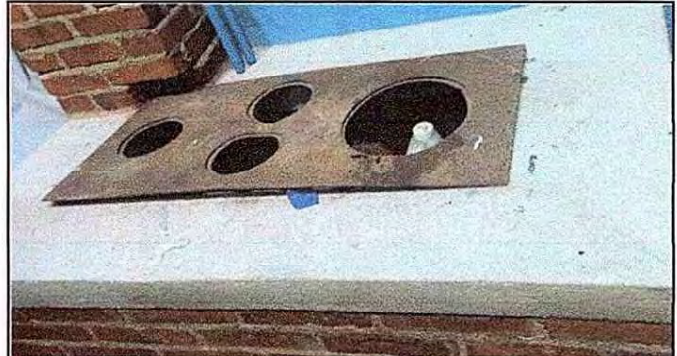
Foto 16: 20.3 Sustitución de plancha de metal de 3 hornillas
