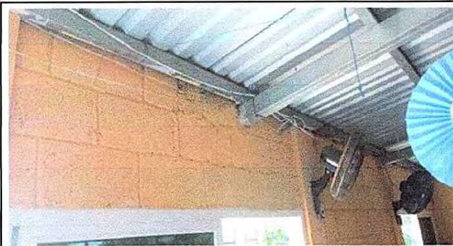
Foto 15: 17.12 Sustitución de ducto eléctrico + accesorios
