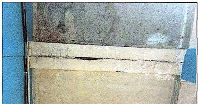
Foto 18: Sellado de grietas y fisuras en muros
