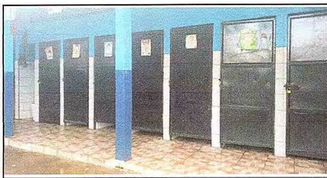
Foto 5: 4.4 Sustitución de puertas en servicios sanitarios
