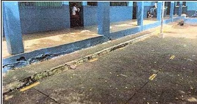
Foto 8: 8.2 Reparación de banquetas de concreto
