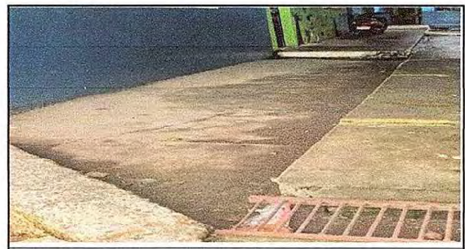
Foto 6: Reparación de cuneta de concreto
