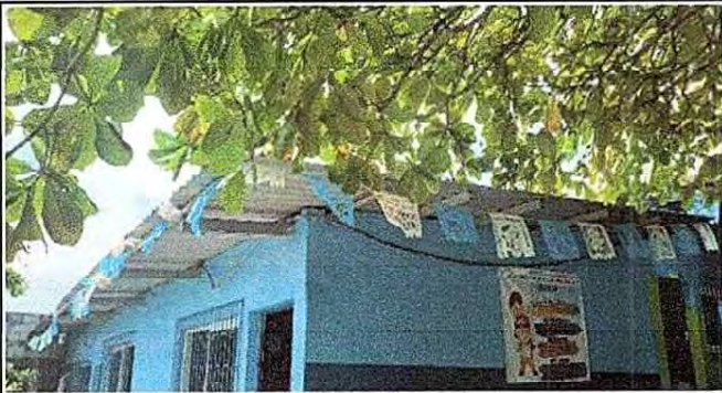
Foto13: 17.12 Sustitución de ducto eléctrico + accesorios
