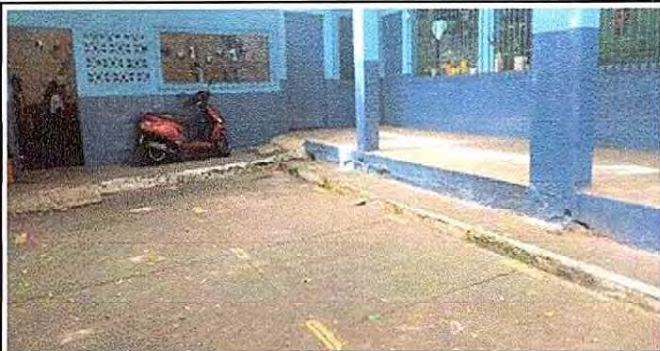
Foto 7: 8.2 Reparación de banquetas de concreto
