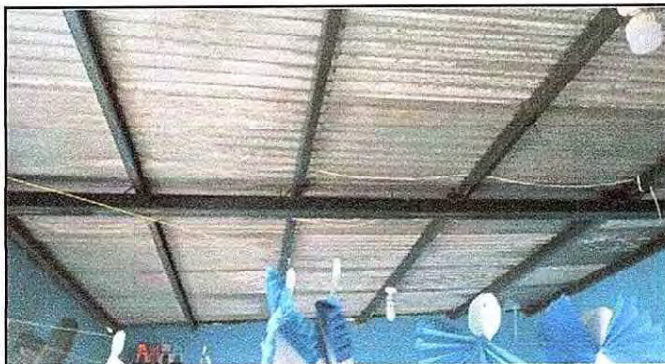
Foto 3: 2.1 Mantenimiento a estructura de soporte de metal
