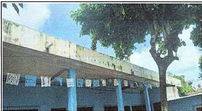
Foto 10: 9.1 Pintura en muros exteriores e interiores
