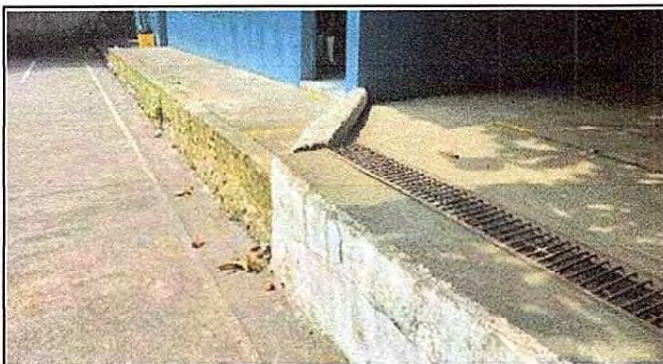
Foto 9: 8.2 Reparación de banquetas de concreto
