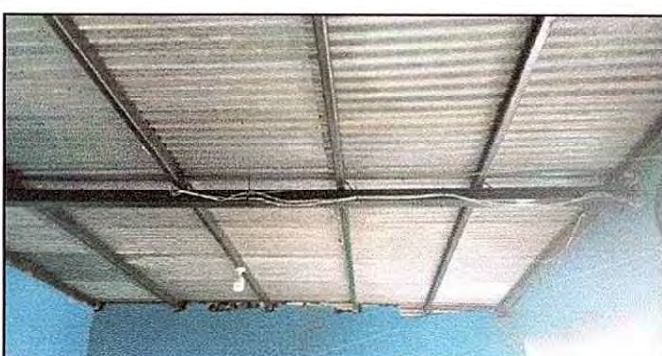
Foto 12: 17.12 Sustitución de ducto eléctrico + accesorios
