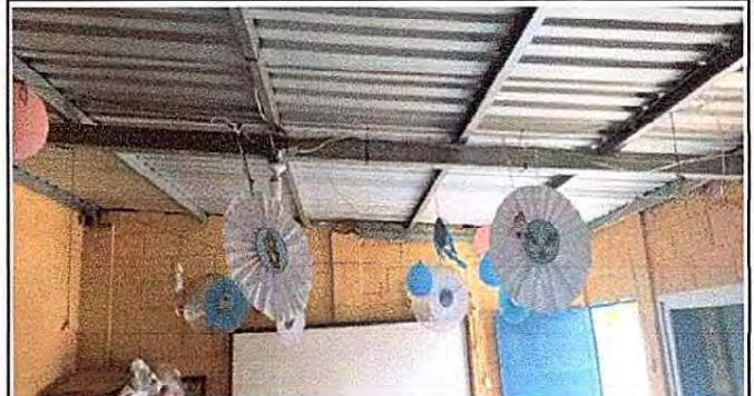
Foto 14: 17.12 Sustitución de ducto eléctrico + accesorios
