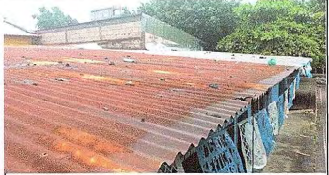
Foto 2: 1.1 Sustitución de lámina por lámina troquelada aluzinc calibre 26 1.3 Sustitución de elementos de fijación
