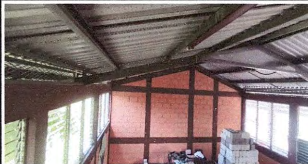
Foto 2: Colocación de lámina metalizada en el módulo 4 del segundo nivel.
