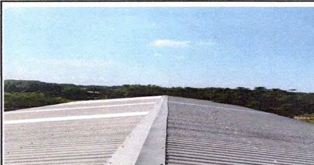
Foto 6: Colocación de lámina troquelada aluzin en el módulo 5 del segundo nivel.
