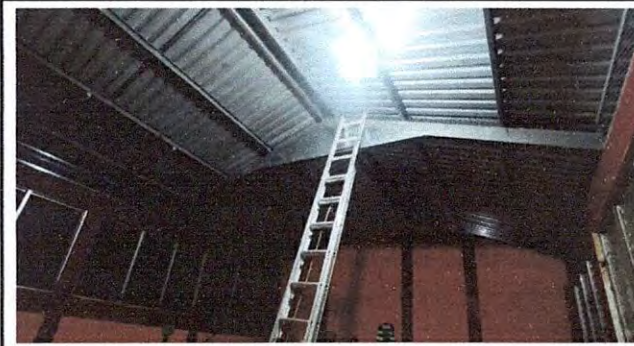
Foto 4: Colocación de lámina metalizada en la costanera del módulo 5 del segundo nivel
