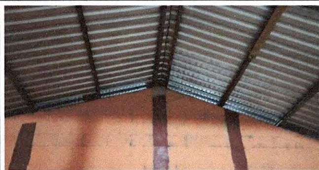
Foto 3: Colocación de lámina metalizada en el caballete del módulo 6 del segundo nivel
