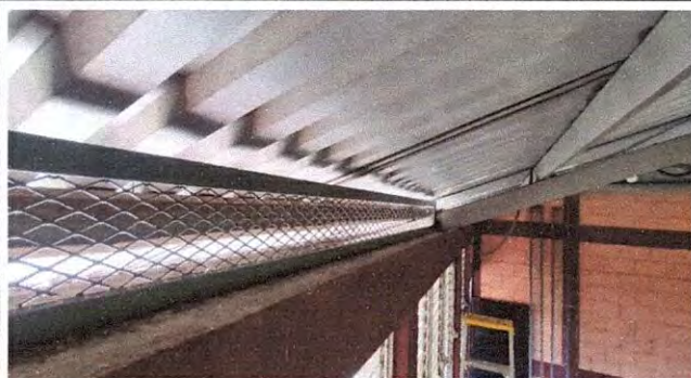
Foto1: Colocación de maya metalizada en el módulo 5 del segundo nivel.
