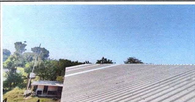
Foto 5: Colocación de lámina troquelada aluzin en los módulos 4 y 5 del segundo nivel.
