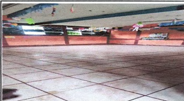
Foto 2: Colocación y sizado de piso cerámico en el modulo 1 del primer nivel
