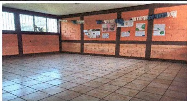
Foto 3: Colocación y sizado finalizado en el módulo 3 del Primer nivel.
