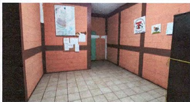
Foto 1: Colocación y sizado de piso cerámico finalizado en el modulo de Dirección.
