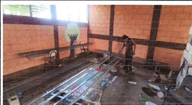
Foto 2: Ensamblaje con lámina metalizada para los caballetes de los módulos 2, 3, 4 y salón de computación del segundo nivel.
