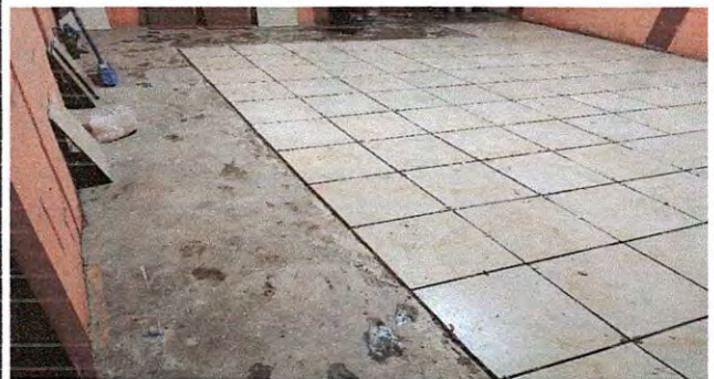
Foto 2: Colocación de Piso en la dirección
