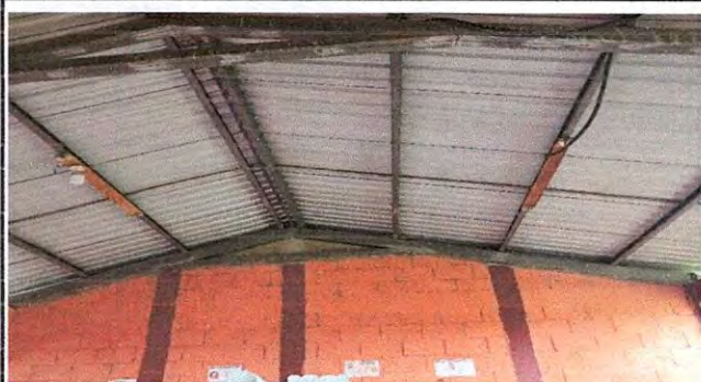
Foto1: Limpieza del costaneras y caballetes del módulo 2 del segundo nivel.
