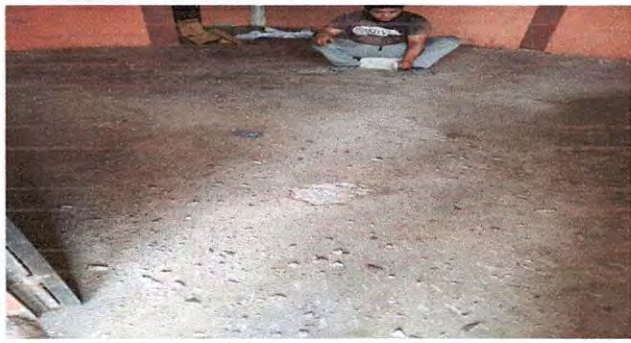
Foto 1: Picado de piso en el módulo de la dirección.
