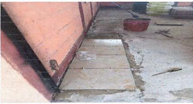
Foto 3: Inicio de colocación de piso en el módulo 3 del primer nivel.
