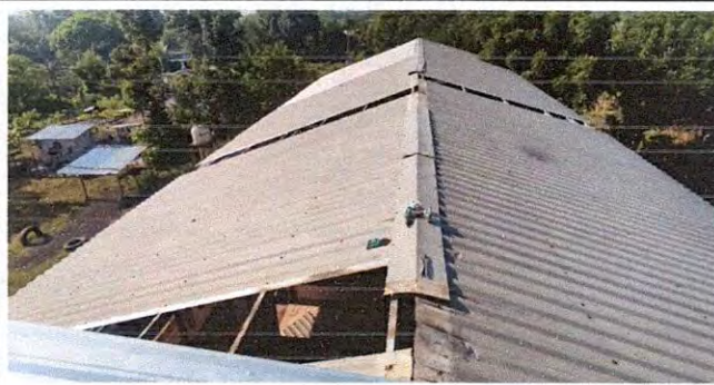
Foto 3: Desmontar y cambiar lámina en los módulos 4 y 5 del segundo nivel.
