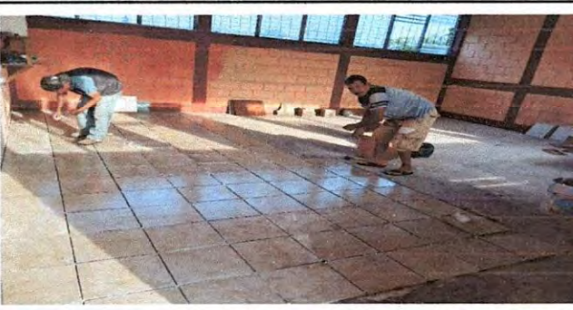
Foto 5: Se pica el piso y posteriormente se realiza la colocación de piso en el módulo 2 del primer nivel.
