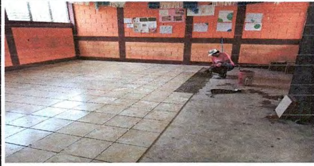
Foto 4: Avanzando en la colocación del piso en el módulo 5 del segundo nivel
