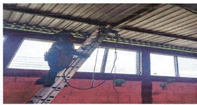
Foto 5: Soldando la lámina metalizada en el caballete en el módulo 2 del segundo nivel.
