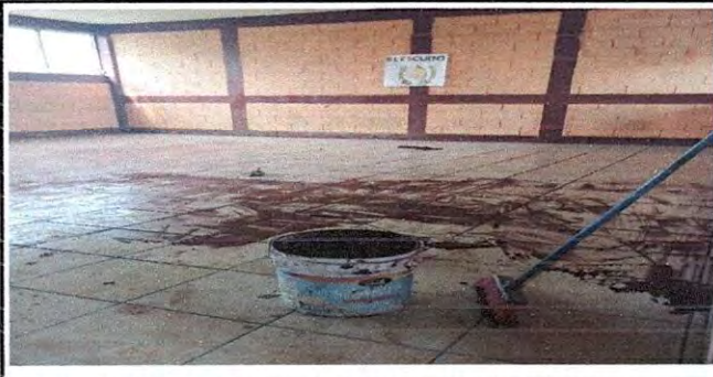
Foto 6: Aplicación de sizado en el módulo 3 del primer nivel
