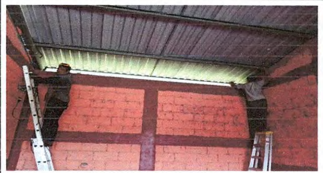
Foto 6: Colocación de lámina metalizada en las gradas del segundo nivel.
