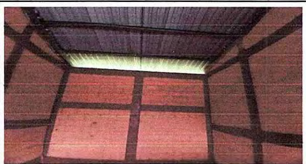
Foto 5: Instalación de lámina metalizada entre la lamina del techo y techo en las gradas
