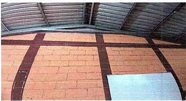
Foto 1: Instalación de lámina troquelada y lamina metalizada en los caballetes del modulo 5 y piso
