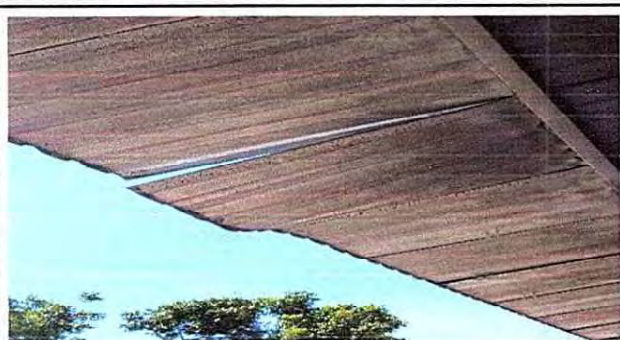
Foto 1: Sustrucción de lámina troquelada en modulo 5 del segundo nivel
