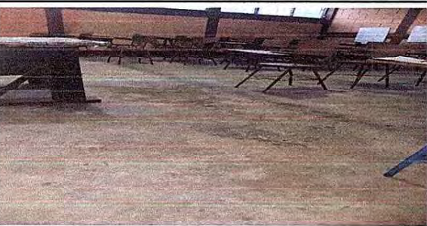
Foto 5: Sustitución de piso en el modulo 2
