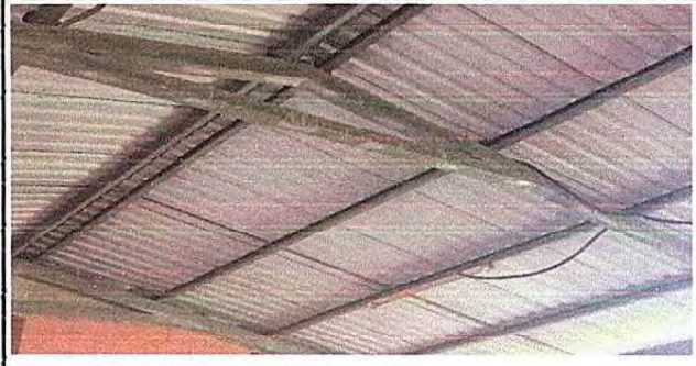
Foto 2: Instalación de lamina troquelada y lamina metalizada entre techo y viga del modulo 4 y piso
