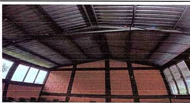
Foto 6: Instalación de lámina metalizada en los caballetes del techo del segundo nivel del módulo 6
