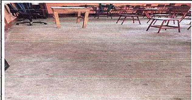
Foto 4: Sustitución de piso en el modulo 1
