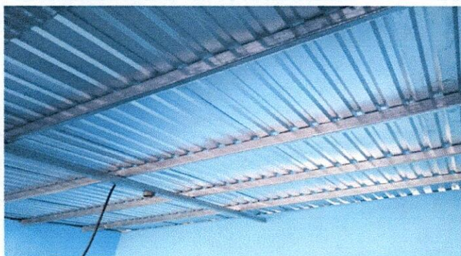
Foto1: Instalación finalizada de estructura portante y lámina en salón de tercero básico
