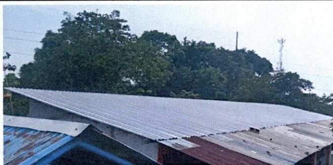
Foto 5: Techo finalizado al 100% en los 3 salones y dirección.
