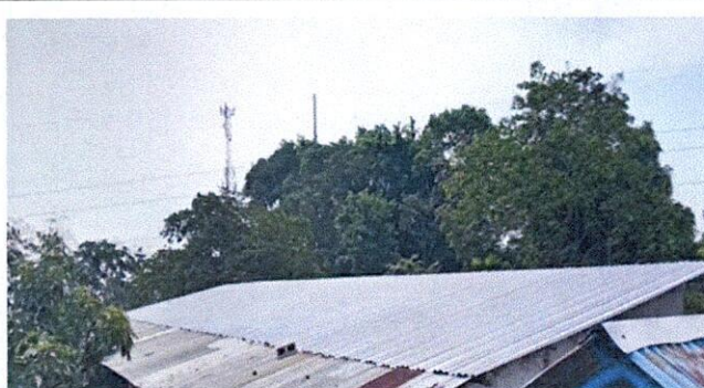
Foto 6: Remozamiento finalizado al 100% INEB DE TELESECUNDARIA
