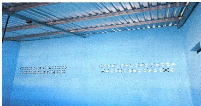
Foto 4: Instalación finalizada de estructura portante y lámina en el salón de segundo básico
