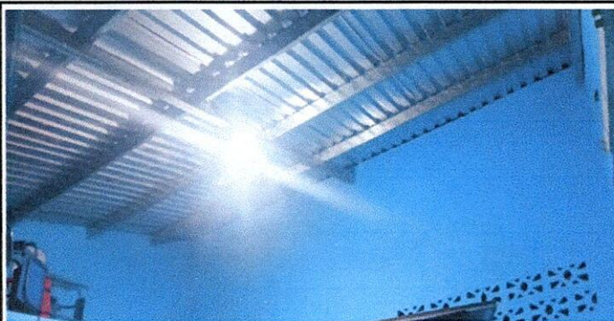
Foto 3: Instalación finalizada de estructura portante y lámina en dirección.
