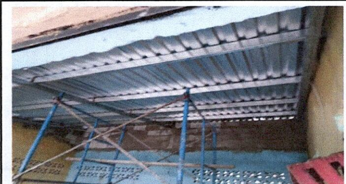
Foto 5: Instalación de lámina troquelada en salón de tercero básico
