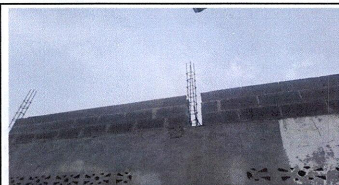
Foto 3: Reparación del muro perimetral
