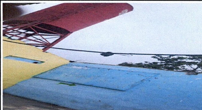
Foto 2: Desinstalación de estructura portante en salones
