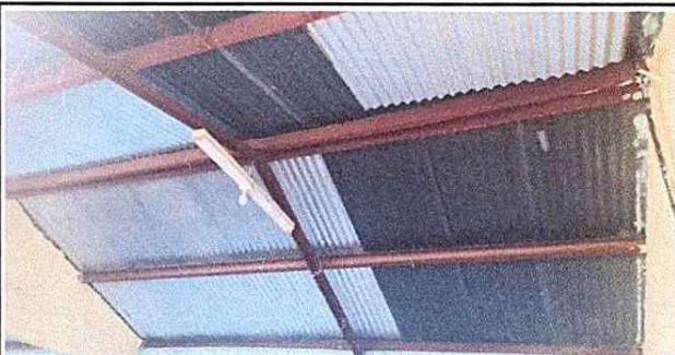
Foto 4: Sustitución de estructura de soporte de metal, por metal en salón de primero básico
