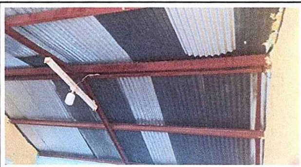
Foto 2: Sustitución de estructura de soporte de metal, por metal en salón de tercero básico.
