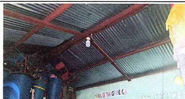
Foto 5: Sustitución de estructura de soporte de metal, por metal en dirección
