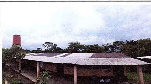
Foto 1: Sustitución de lámina, por lámina troquelada aluzinc calibre 26, y sustitución de capote de lámina para lámina troquelada en salones y dirección.
