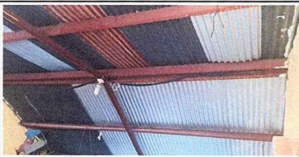
Foto 3: Sustitución de estructura de soporte metal, por metal en salón de segundo básico.
