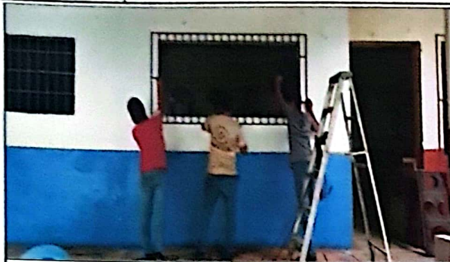
Foto 7: Mantenimiento en puertas y valcones.
