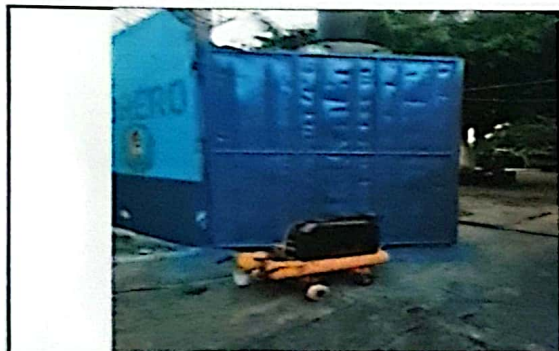
Foto 9: Mantenimiento en porton en exterior y interior.
