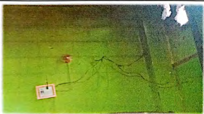
Foto 9: Cambio e instalación de sistema eléctrico (fuerza e iluminación) incluye ducto, cajas octogonales, abrazaderas, cables, interruptores, plafoneras, focos ahorradores de alta potencia y tomacorrientes.
