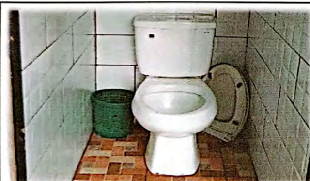
Foto 3: Una de las necesidades que se evaluarán en este modulo es el cambio e instalación del incluye kit de accesorios, tapadera, manguera para inodoros.
