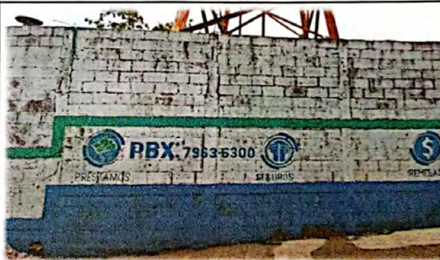
Foto 10: Es importante la aplicación de pintura en muro perimetral doble cara (dos manos) mas rotulación.
