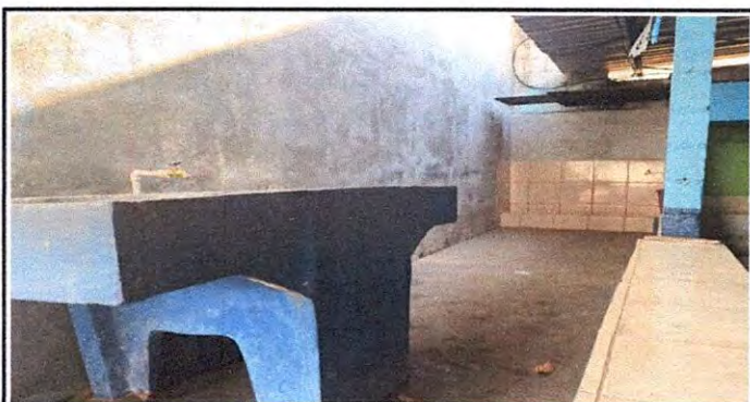
Foto 5: Sustitución de Mingitorio
