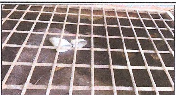
Foto 6: Sustrucción de tubería línea principal
