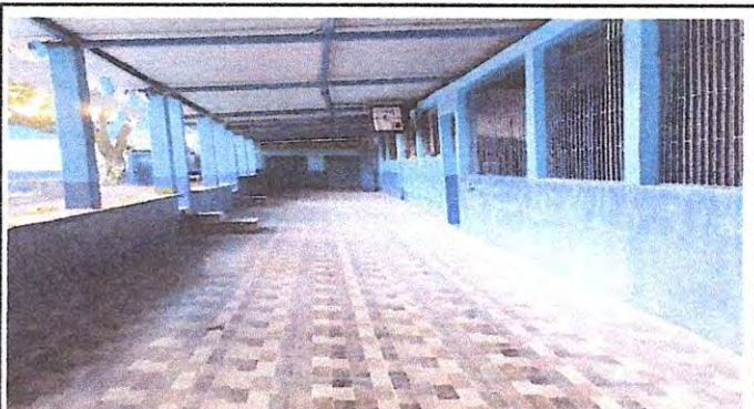
Foto 4: Sustrucción de piso de torta de cemento
