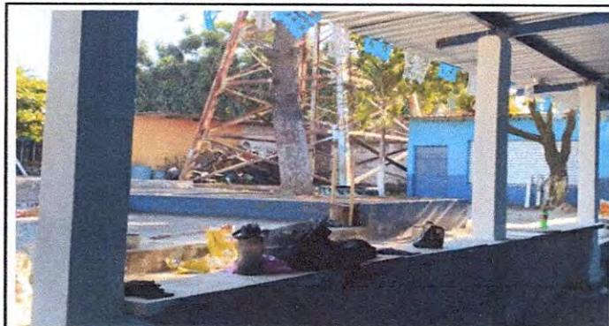
Foto 1: Sellado de grietas y fisuras de muros.
