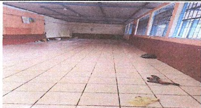
Foto1: Sustrucción de piso de torta de cemento
