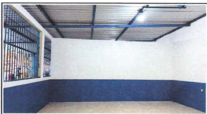
Foto 4: Sustitución de paredes de divisiones metálicas por tablayeso
