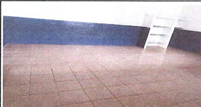
Foto2: Sustrucción de piso de torta de cemento
