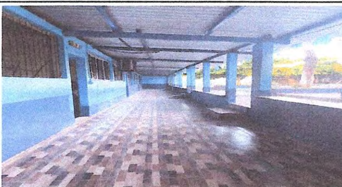
Foto3: Sustrucción de piso de torta de cemento
