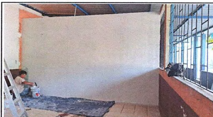
Foto 3: Sustitución de paredes de divisiones metálicas por tablayeso
