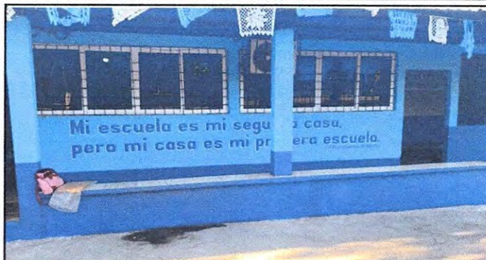
Foto 2: Sellado de grietas y fisuras de muros.
