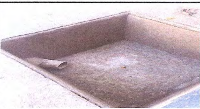
Foto 5: Sustrucción de tubería línea principal
