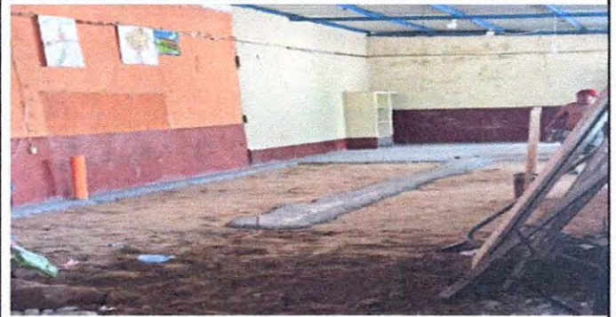
Foto 2: Aula 6 Sustitución de piso torta de concreto
