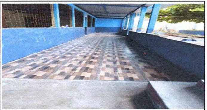
Foto 2: Aula 6 Sustitución de piso torta de concreto
