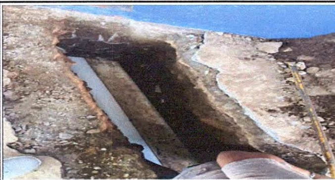
Foto 5: Sustitución de tubería línea principal
