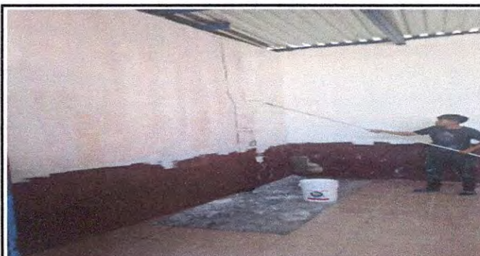
Foto 6: Pintura en muros interiores y exteriores
