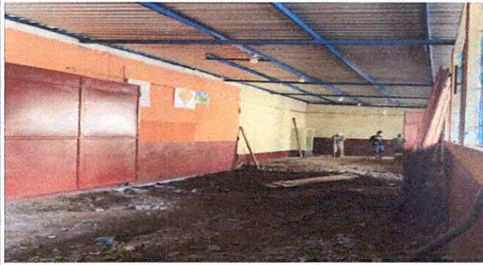
Foto1: Aula 4,5 y 6 Reparación de piso de torta de cemento
