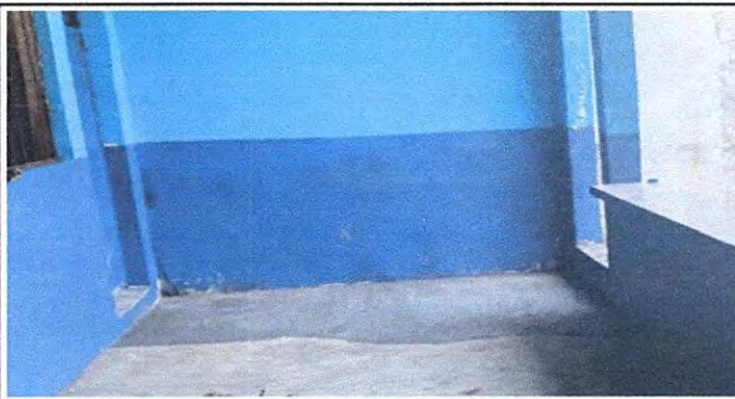
Foto 3: Aula 06 Reparación de piso de torta de cemento
