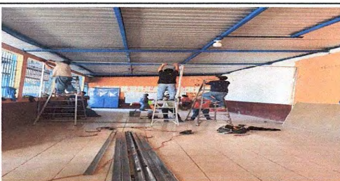
Foto 3: Sustitución de paredes de divisiones metálicas por tablayeso
