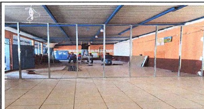
Foto 4: Sustitución de paredes de divisiones metálicas por tablayeso
