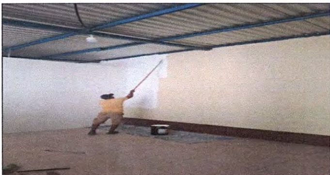
Foto 5: Pintura en muros interiores y exteriores
