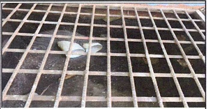
Foto 6: Sustitución de tubería línea principal
