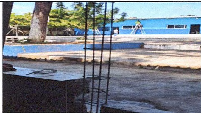
Foto 1: Sellado de grietas y fisuras de muros.
