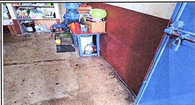
Foto 1: Aula 6 Reparación de piso de torta de cemento
