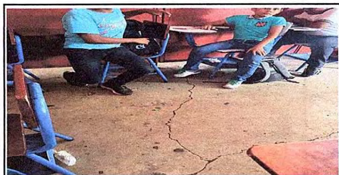
Foto 5: Aula 5 Reparación de piso de torta de cemento
