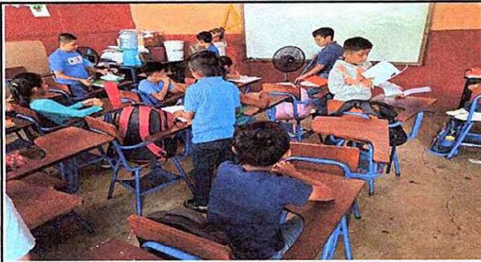
Foto1: Aula 5 Reparación de piso de torta de cemento
