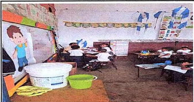
Foto 3: Aula 4 Reparación de piso de torta de cemento
