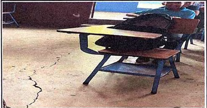
Foto 2: aula 5 Sustitución de piso torta de concreto
