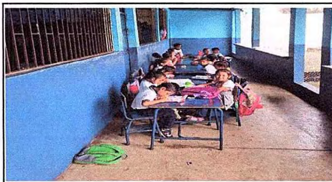
Foto 4: Niños del aula 6 recibiendo sus clases en el corredor por deterioro del aula, Reparación de piso de torta de cemento
