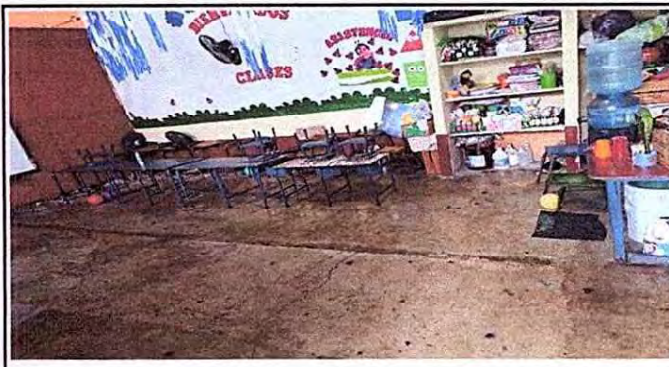
Foto 2: Aula 6 Sustitución de piso torta de concreto
