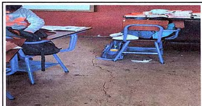
Foto 6: Aula 5 Reparación de piso de torta de cemento
