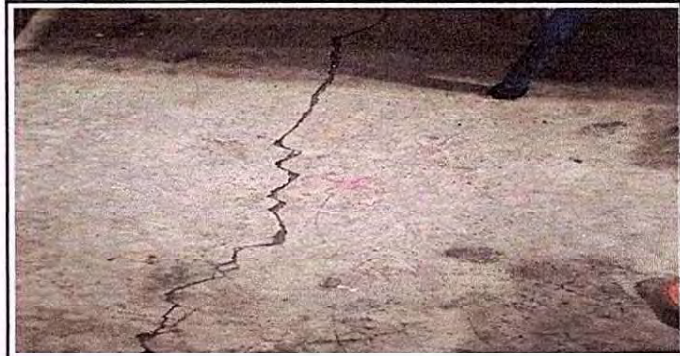
Foto 4: Aula 4 Reparación de piso de torta de cemento
