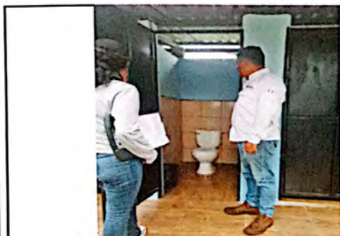
Foto 5: Sustitución de azulejo y piso cerámico antideslizante, en módulo de servicios sanitarios. Finalizado.
