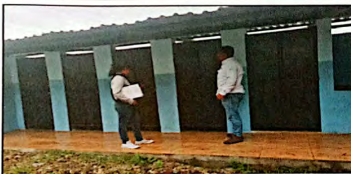
Foto 4: Presidente de OPF, entrega la sustitución de 7 puertas de metal para cada cubículo de inodoros. Finalizado.
