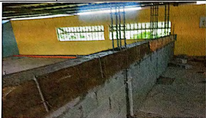
Foto 7: Se supervisa la fundición de viga intermedia, en la división de los salones de clases. Proceso de ejecución.
