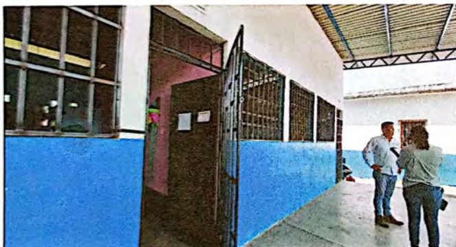
Foto 9: Evaluadora de campo supervisa la intalación de algunos balcones ya instalados en los salones de clases.
