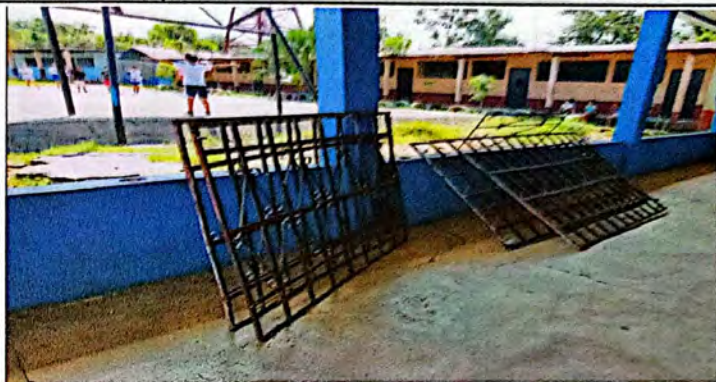
Foto 8: Evaluadora de campo supervisa la desinstalación de los balcones en mal estado de los salones de clases, para su respectivo mantenimiento.
