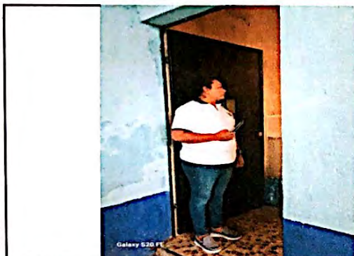
Foto 3: Herrería, sustitución de puerta, incluye pintura y chapa en módulo de cocina, finalizado al 100%
