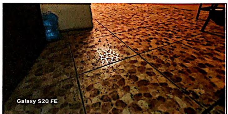
Foto 4: Cambio e instalación de piso antideslizante 5.00 m 2.80 m (cocina), finalizado al 100%
