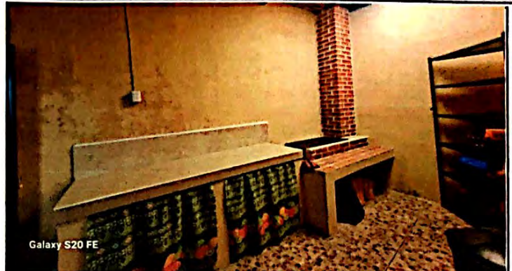
Foto 2: Mejoramiento modulo de cocina, incluye remozamiento de estufa de leña rural, muebles de concreto fijos, y azulejo, finalizado al 100%
