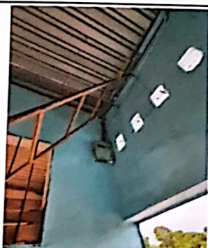
Foto 11: Traslado de caja de flipones en el primer salón hacia la parte superior del ingreso.
