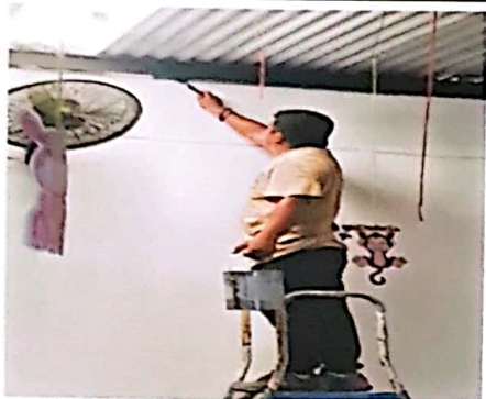
Foto 7: Mantenimiento en costaneras de metal.
