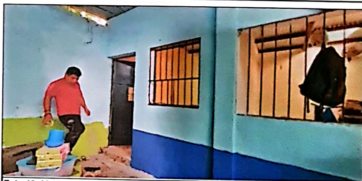
Foto 10: Mejoramiento en pintura en muros exteriores.
