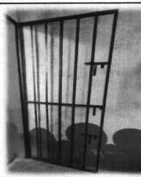
Foto 6: Es necesaria la sustitución de puerta , incluye pintura y chapa.
