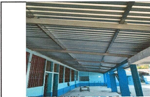
Foto 4: Corredor cambio de estructura portante y lámina
