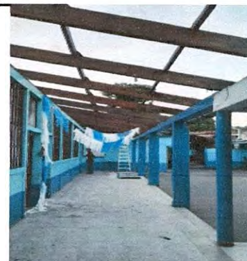
Foto 4: Corredor cambio de estructura portante y lámina
