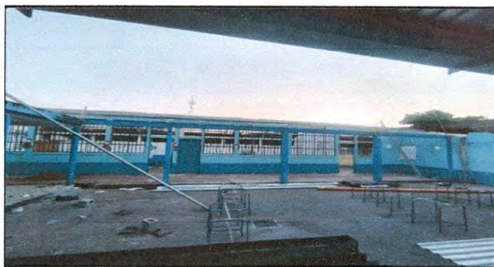
Foto 5: Frente de las aulas a remozar
