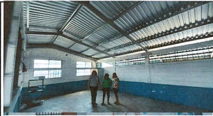
Foto1: Salón No. 1 Cambio de estructura portante y lámina
