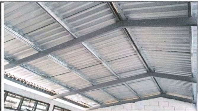
Foto 2: Salón No. 2 Cambio de estructura portante y lámina
