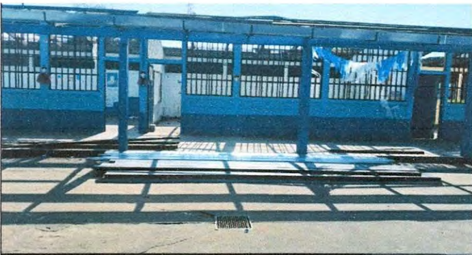
Foto 5: Frente de las aulas a remozar
