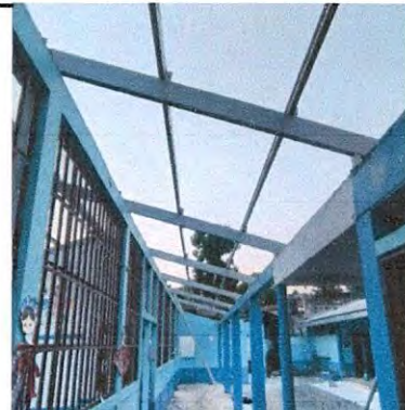
Foto 4: Corredor cambio de estructura portante y lámina
