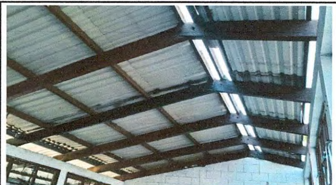
Foto 2: Salón No. 2 Cambio de estructura portante y lámina
