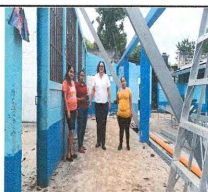
Foto 4: Corredor cambio de estructura portante y lámina
