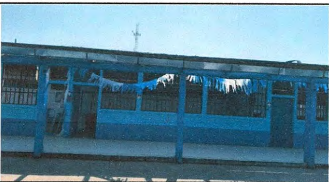
Foto 5: Frente de las aulas a remozar
