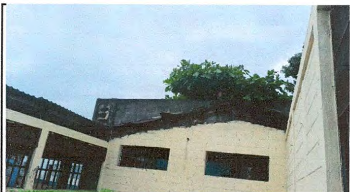
Foto 3: Salón No. 3 Cambio de estructura portante y lámina
