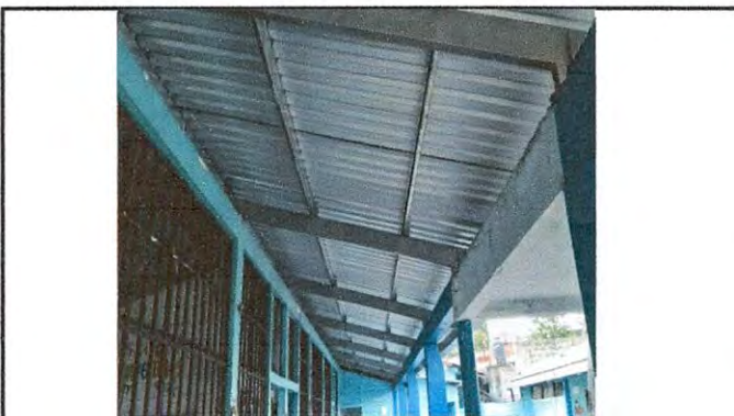
Foto 4: Corredor cambio de estructura portante y lámina
