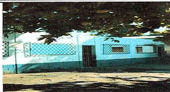
Foto 2: Vista frontal de los salones a remozar.
