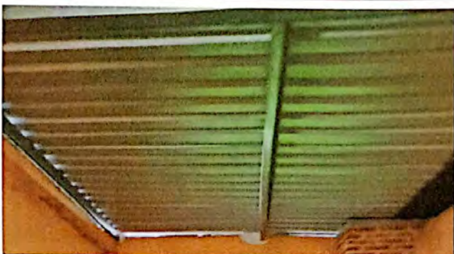
Foto 9: Cambio e instalación de lamina por lamina troquelada aluzinc calibre 26 (incluye pernos) en módulo de cocina, finalizado al 100%.
