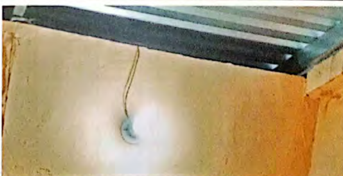
Foto 10: Cambio e instalación de sistema electrico en módulo de cocina (fuerza e iluminación) incluye ducto, cajas octogonales, abrazaderas, cables, interruptores, plafoneras, focos ahorradores de alta potencia y tomacorrientes. Finalizado al 100%.
