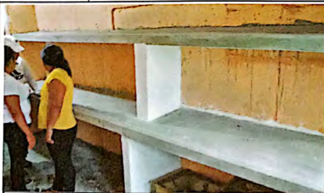
Foto 7: Mejoramiento de cocina (modulo 5.20 m x 5.40 m) incluye remozamiento de muebles de cocina. Finalizado al 100%.
