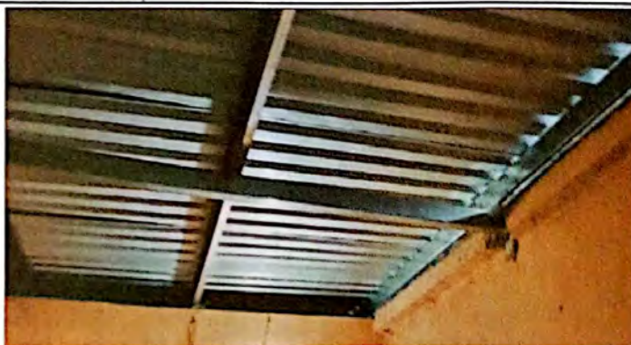
Foto 8: Cambio e instalación de estructura de soporte metal por metal en el módulo de cocina. Finalizado al 100%.
