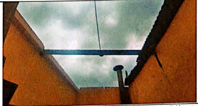
Foto 6: Se pudo observar que se tiene el desmontaje de lamina para sustituirla por lamina aluzinc calibre 26 en modulo de cocina.
