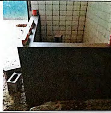
Foto 2: Cambio e instalación de pila de plástico por pileta fundida en el módulo de servicios sanitarios.
