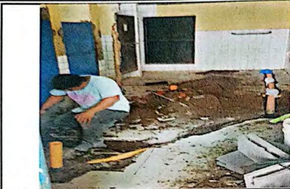
Foto 1: Mejoramiento en servicios sanitarios incluye reparación de tubería de drenaje. Se observan los trabajos de excavación y sustitución de la tubería sanitaria.
