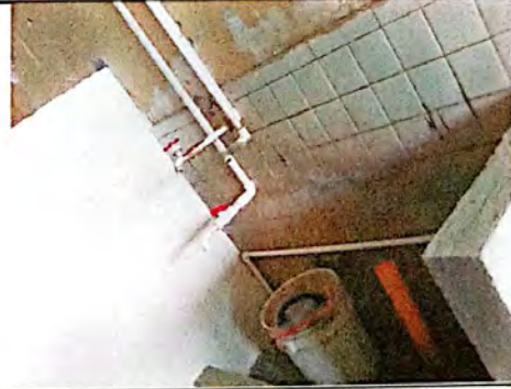
Foto 4: Cambio e instalación de tubería pvc mas artefactos como parte del mejoramiento y reparación del módulo de servicios sanitarios.
