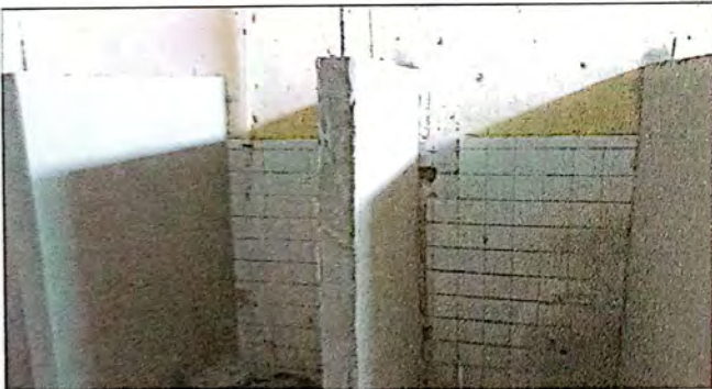
Foto 3: Reparación de muros divisores con aplicado de monocapa como parte del mejoramiento y reparación del módulo de servicios sanitarios.
