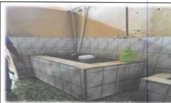
Foto 4: Cambio e instalación de pila de plástico por pileta fundida
