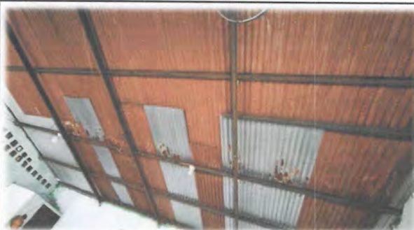
Foto 11: Es necesario el cambio e instalación de estructura de soporte metal por metal.
