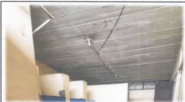
Foto 5: Cambio e instalación de sistema eléctrico (fuerza e iluminación) incluye ducto, cajas octogonales, abrazaderas, cables, interruptores, plafoneras, focos ahorradores de alta potencia y tomacorrientes.
