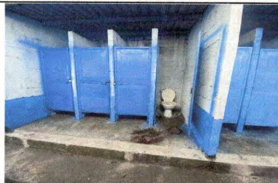
Foto 4: Modulo de baños
