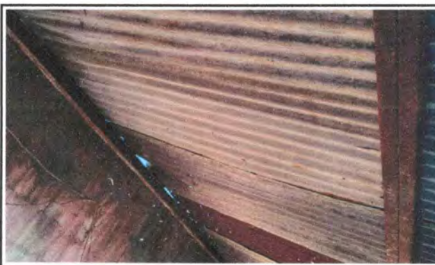
Foto 4: Techo de aula 1
