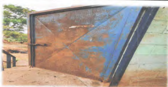
Foto 5: Las puertas de los inodoros se encuentran oxidadas, se evalua la necesidad de sustituir por puertas en mejores condiciones.
