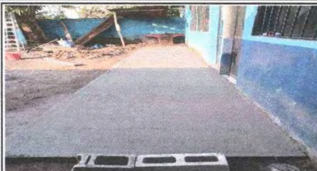
Foto 2: Fundicion de banqueta
