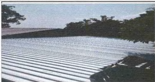
Foto 1: Estructura de metal y laminas instaadas
