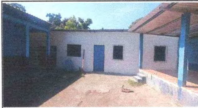
Foto 8: Repello frontal y puerta instalada
