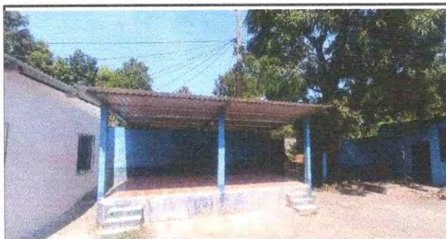
Foto 9: Cambio de techo de escenario e instalacion de piso ceramico
