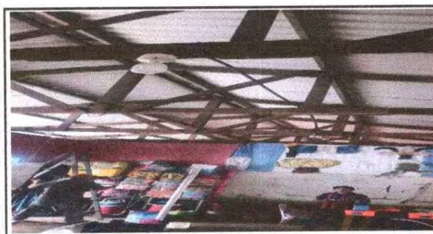
Foto 5: Instalación de sistema electrico
