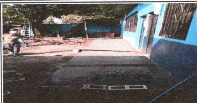
Foto 7: Fundición de torta de cemento
