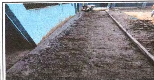
Foto 11: Fundición de cemento
