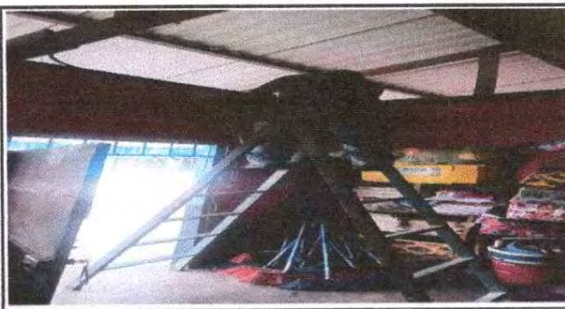
Foto 6: Instalación de sistema electrico
