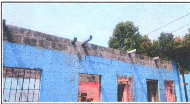
Foto 6: Colocación de estructura de metal
