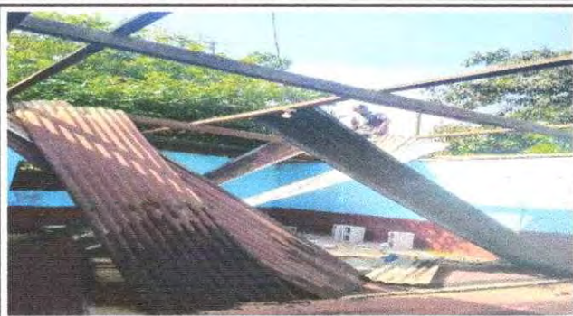
Foto 1: Empieza la desinstalación de la estructura deteriorada
