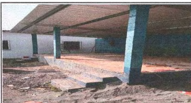
Foto 10: Colocación de piso ceramico en el escenario
