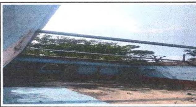
Foto 5: Colocación de estructura de metal
