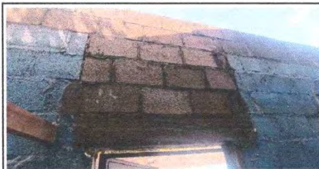
Foto 12: Reparación de muro
