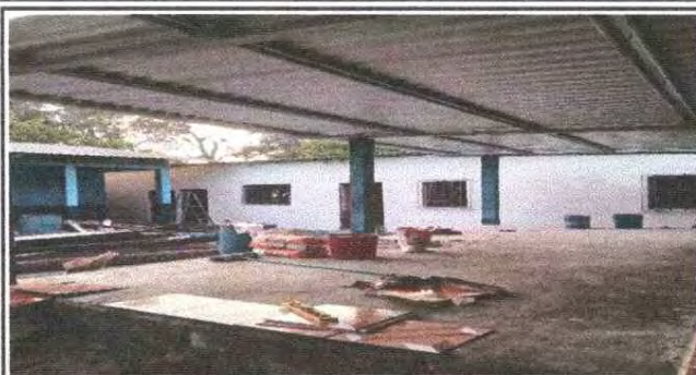
Foto 8: Colocación de piso ceramico en el escenario
