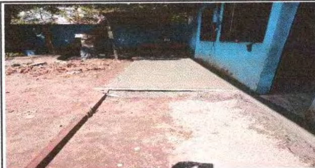
Foto 8: Fundición de cemento
