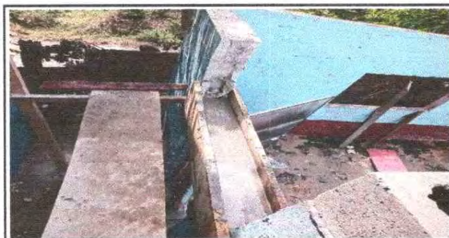
Foto 11: Reparación de muro
