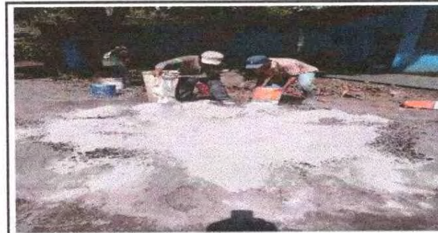
Foto 12: Fundición de cemento
