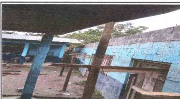
Foto 4: Levantado de tres hiladas de block en toda el area a remodelar
