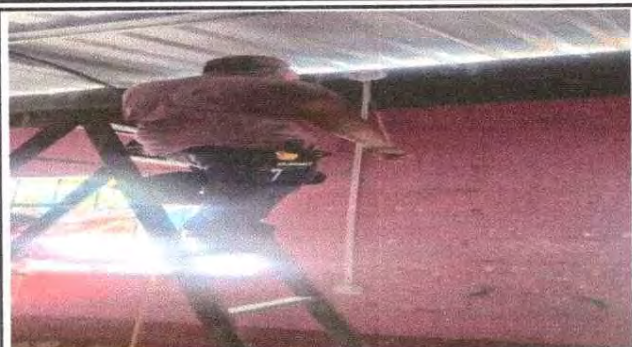
Foto 1: Instalación de sistema electrico
