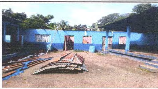
Foto 2: Desinstalación de estructura deteriorada
