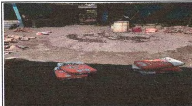
Foto 10: Colocación de piso cerámico en el escenario
