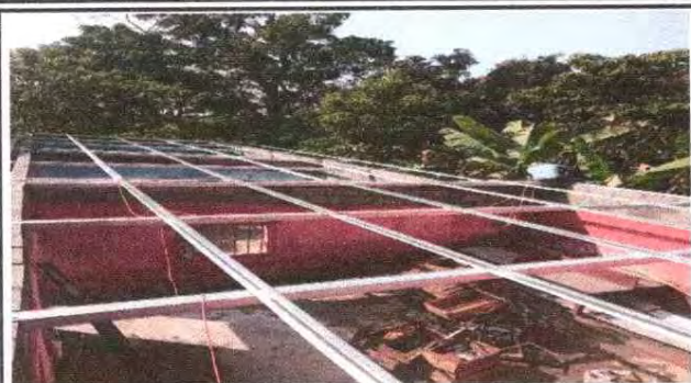
Foto1: Instalacion de estructura de metal
