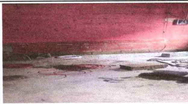
Foto 2: Instalación de sistema electrico
