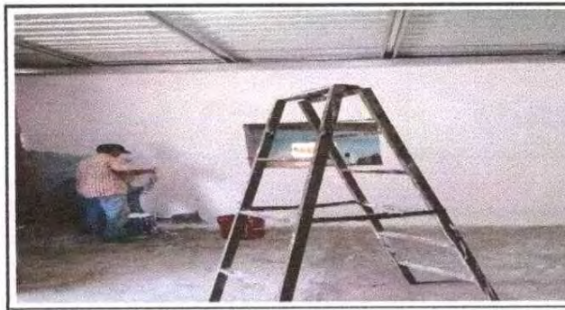
Foto 6: Colocación de estructuta de metal
