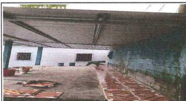
Foto 9: Colocacion de estructura metalica en el escenario
