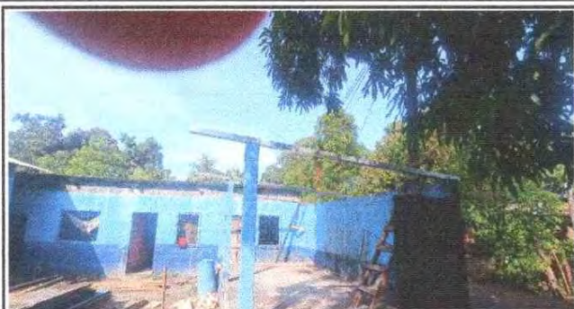
Foto 7: Montaje de estructura de lamina en escenario
