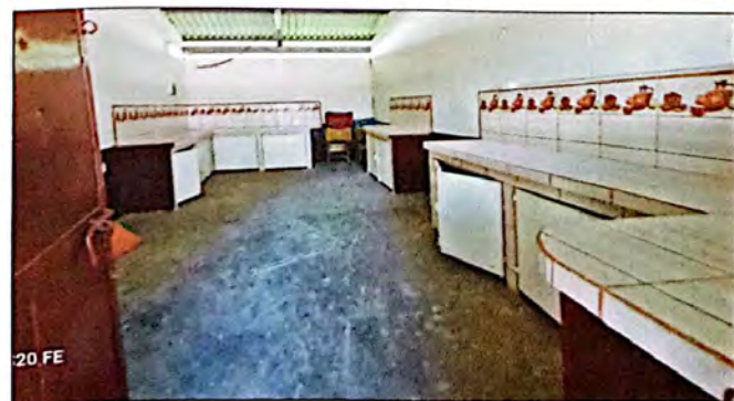
Foto 5: Mejoramiento de cocina (modulo 4.1 m x 8.00 m) incluye remozamiento de muebles de cocina y azulejo. Finalizado al 100%
