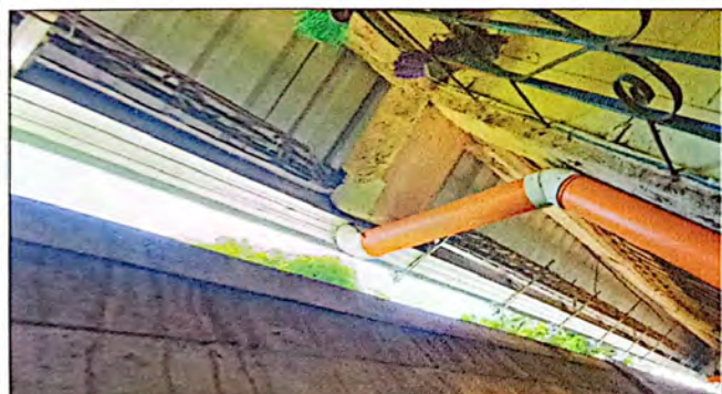
Foto 9: Cambio e instalación de soporte para canal PVC y canal de PVC, finalizado al 100%
