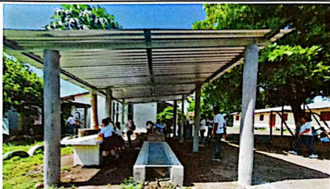
Foto 7: Cambio de lámina por lamina troquelada aluzinc calibre 26 incluye tornillos ubicado en estufa de leña rural. Finalizado al 100%
