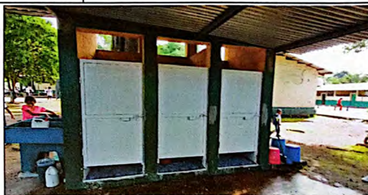
Foto 2: Herrería. Reparación y mantenimiento de puertas en el módulo de servicios sanitarios, finalizada al 100%
