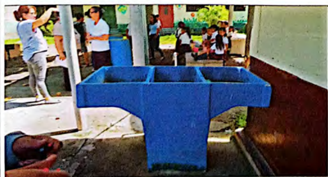
Foto 11: Cambio e instalación de pilas de dos lavaderos, finalizada al 100%
