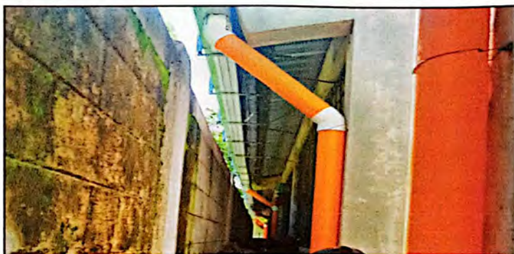
Foto 10: Cambio e instalación de bajada de agua PVC 3" finalizado al 100%
