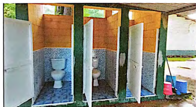
Foto 3: Cambio e instalación de azulejo (1 mt de altura) en módulo de servicios sanitarios, finalizado al 100%
