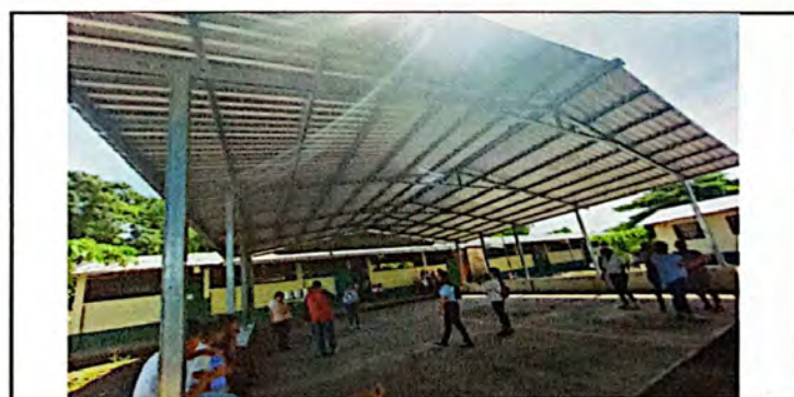
Foto 4: Ampliación, suministro e instalación de galera en el patio No. 1, finalizada al 100%
