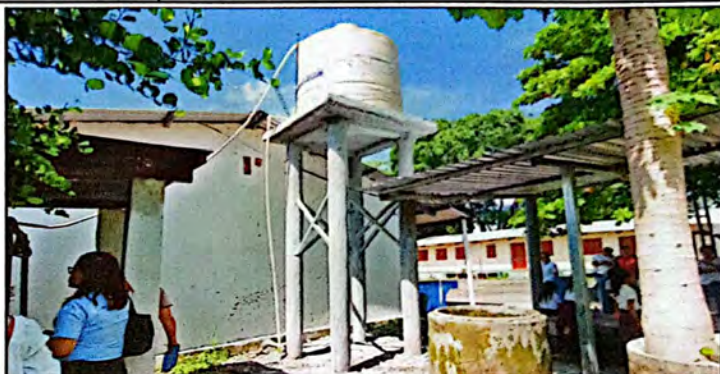
Foto 8: Cambio e instalación de deposito de agua 1100 lts. Finalizado al 100%
