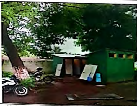
Foto 4: Se cambio lamina troquelada aluzinc calibre 26 en los modulos de servicios sanitarios niños, niñas y docentes.
