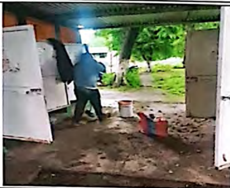
Foto 2: Reparación y mejoramiento en el área de servicios sanitarios.
