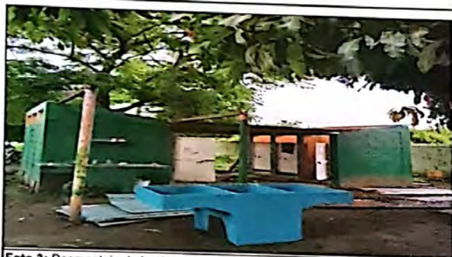
Foto 3: Desmontaje de lamina para el modulo de servicios sanitarios.
