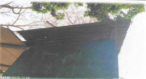
Foto 5: Cambio de lámina por lámina troquelada aluzinc calibre 26 incluye tornillos
