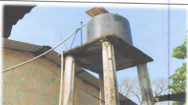
Foto 10: Es importante el cambio e instalación del depósito de agua de 1,100 litros.
